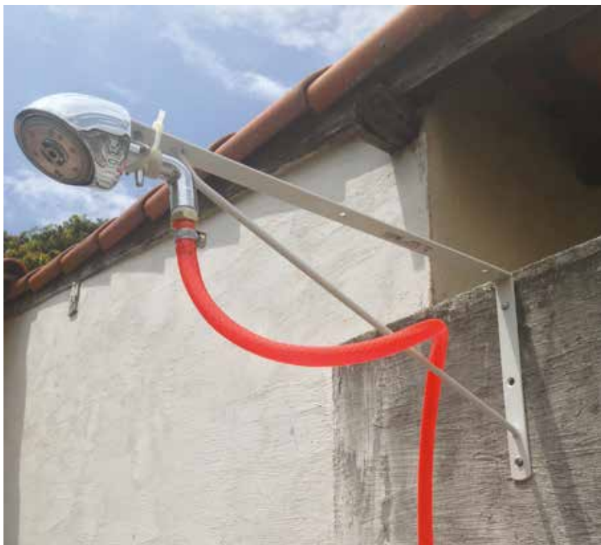
Figura 150 - Chuveiro instalado e fixado na mão francesa. Fonte: Elaboração própria.
