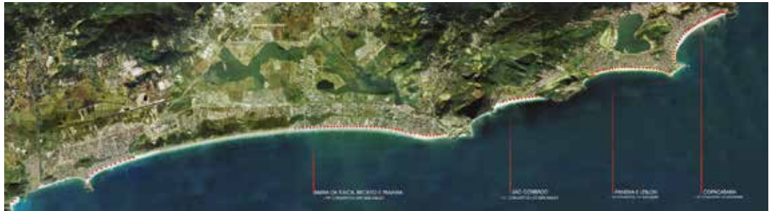
Figura 39 - Área de atuação do projeto: do Leme à Praia. Fonte: Indio da Costa A.U.D.T.
