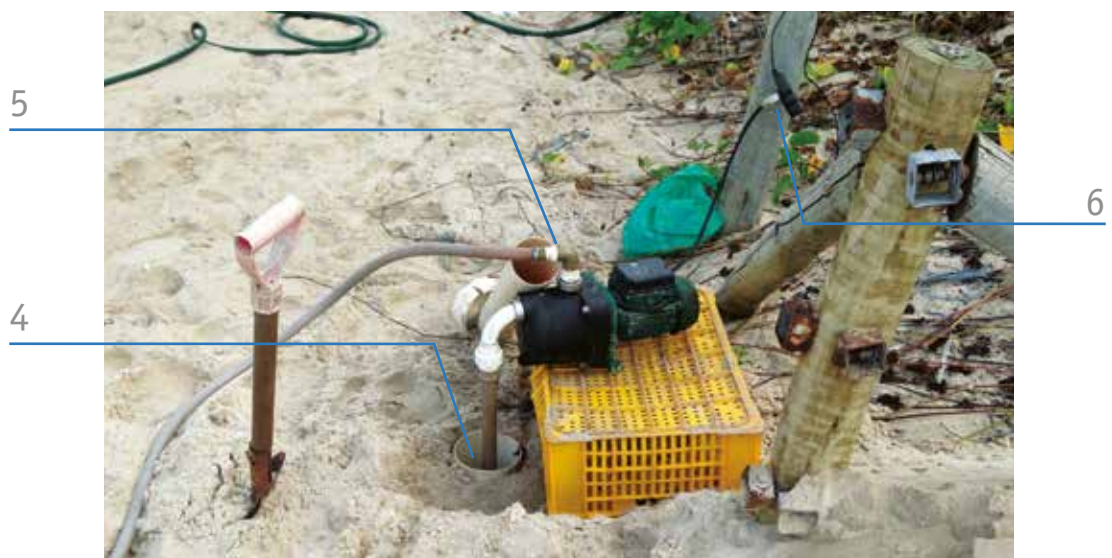
Figura 7 - Uma das bombas usadas para captar água na praia de Ipanema. Fonte: elaboração própria.
