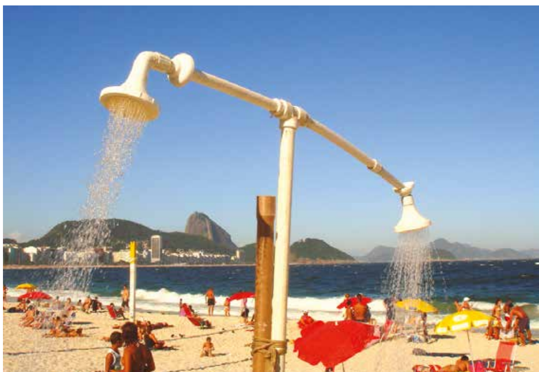
Figura 2 - Exemplo de um dos chuveiros instalados por barraqueiros nas praias do Rio de Janeiro. Fonte: https://www.flickr.com/photos/selusava/5386879461
