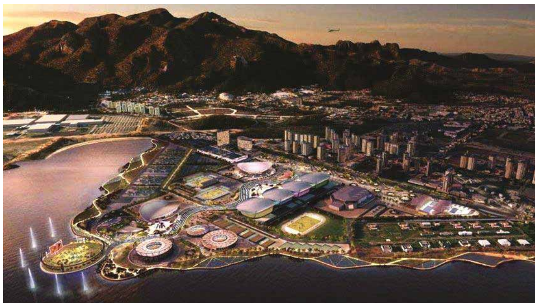
Figura 38 - Parque Olímpico Jogos Rio 2016. Fonte: < http://www.dutchdailynews.com/arcadis-to-perform-project-and-construction-management-services-for-rio-2016-olympic-games/ >.
