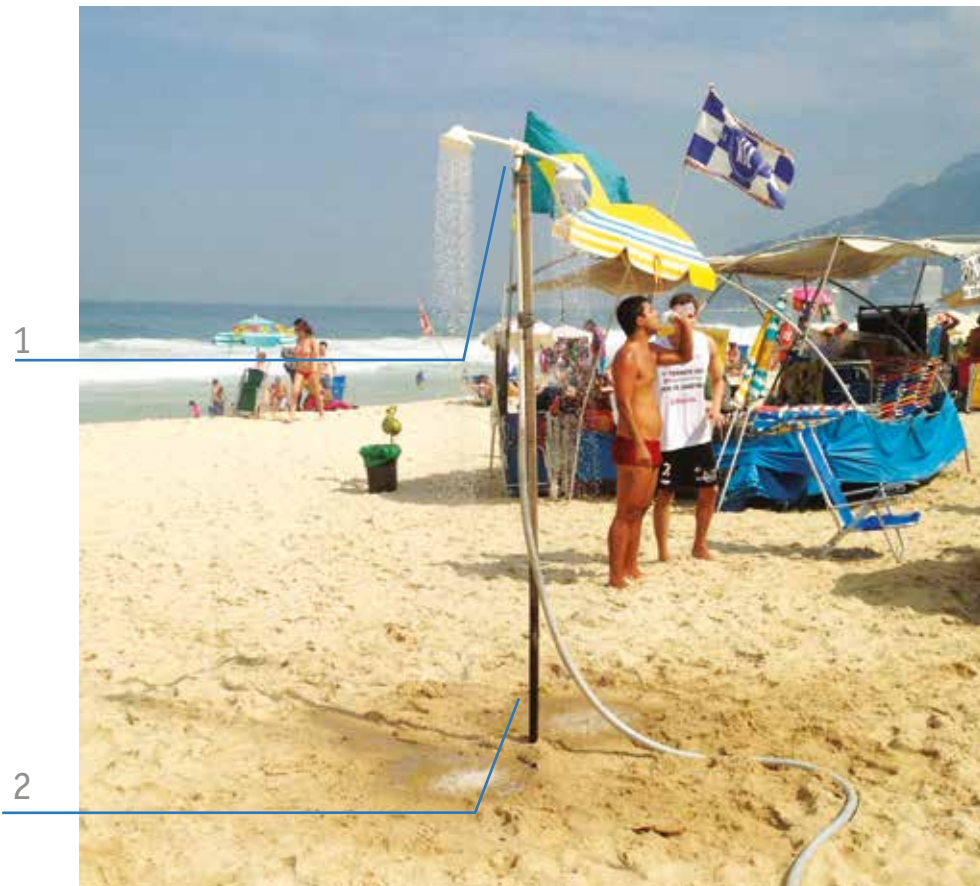
Figura 3 - Exemplo de um dos chuveiros instalados em Ipanema. Fonte: elaboração própria.
