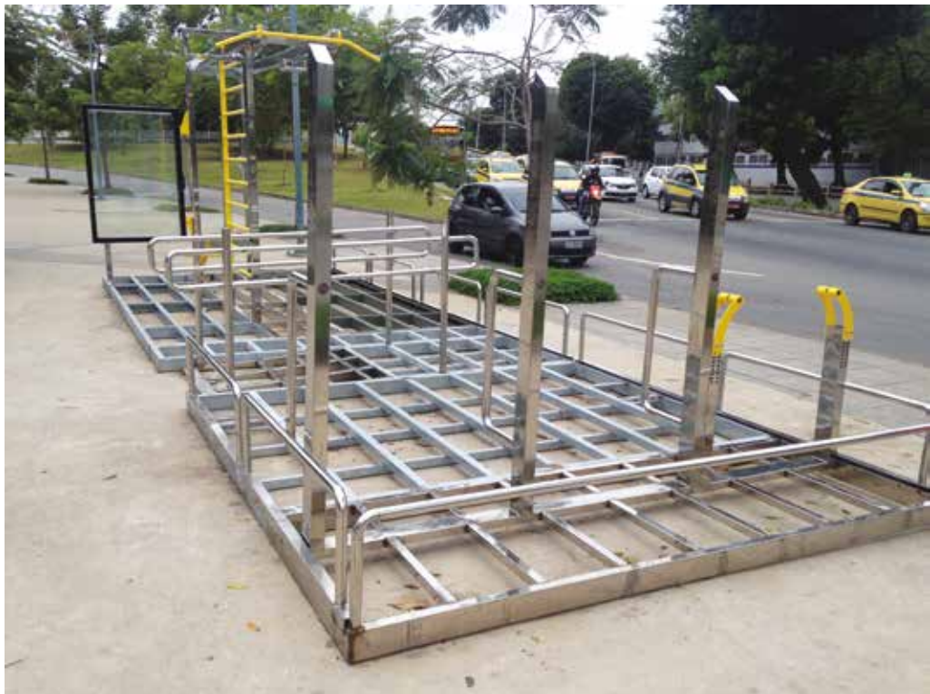
Figura 33 - Essa imagem mostra a parte interna da base de uma dessas estações de alongamento e ginástica. Logo abaixo das tábuas de madeira plástica, há uma trama de tubos de aço galvanizado que garantem a estabilidade do produto em qualquer superfície. Essa estrutura é uma patente da empresa Mude Mobiliários Urbanos. Fonte: elaboração própria.
