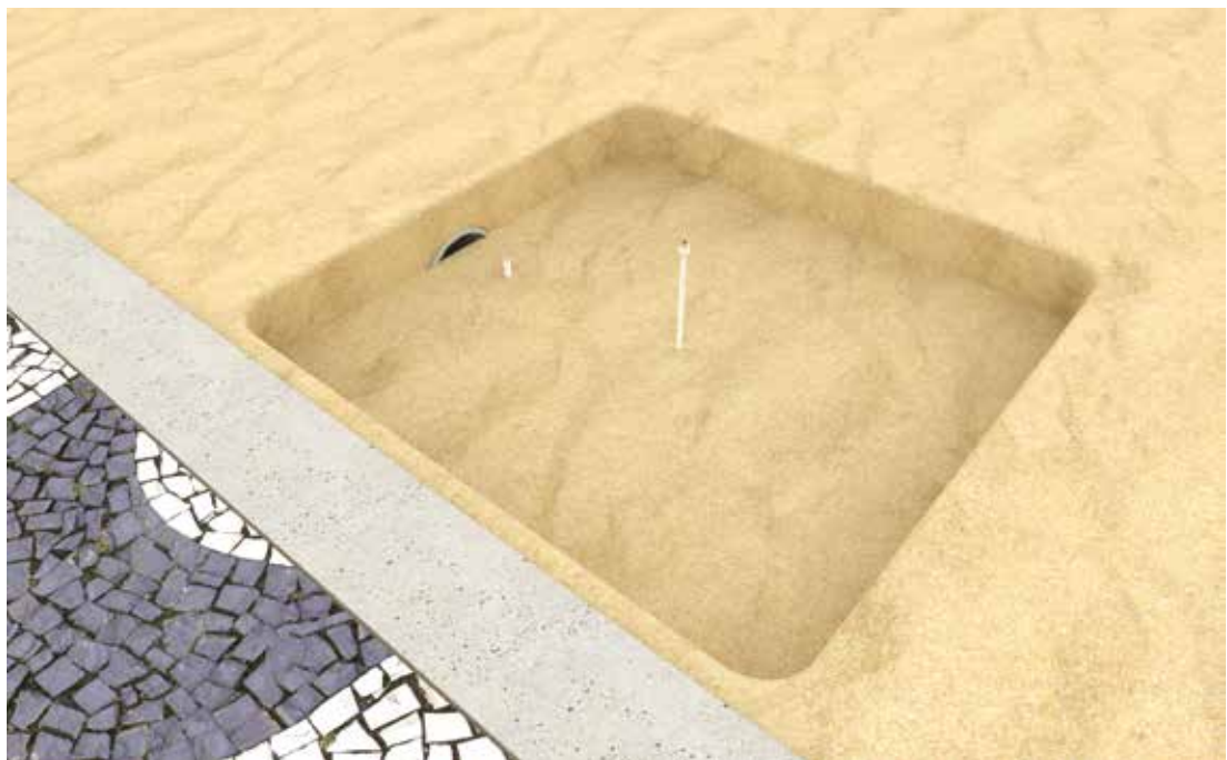
Figura 98 -Preenchimento parcial do buraco. Fonte: Elaboração própria.
