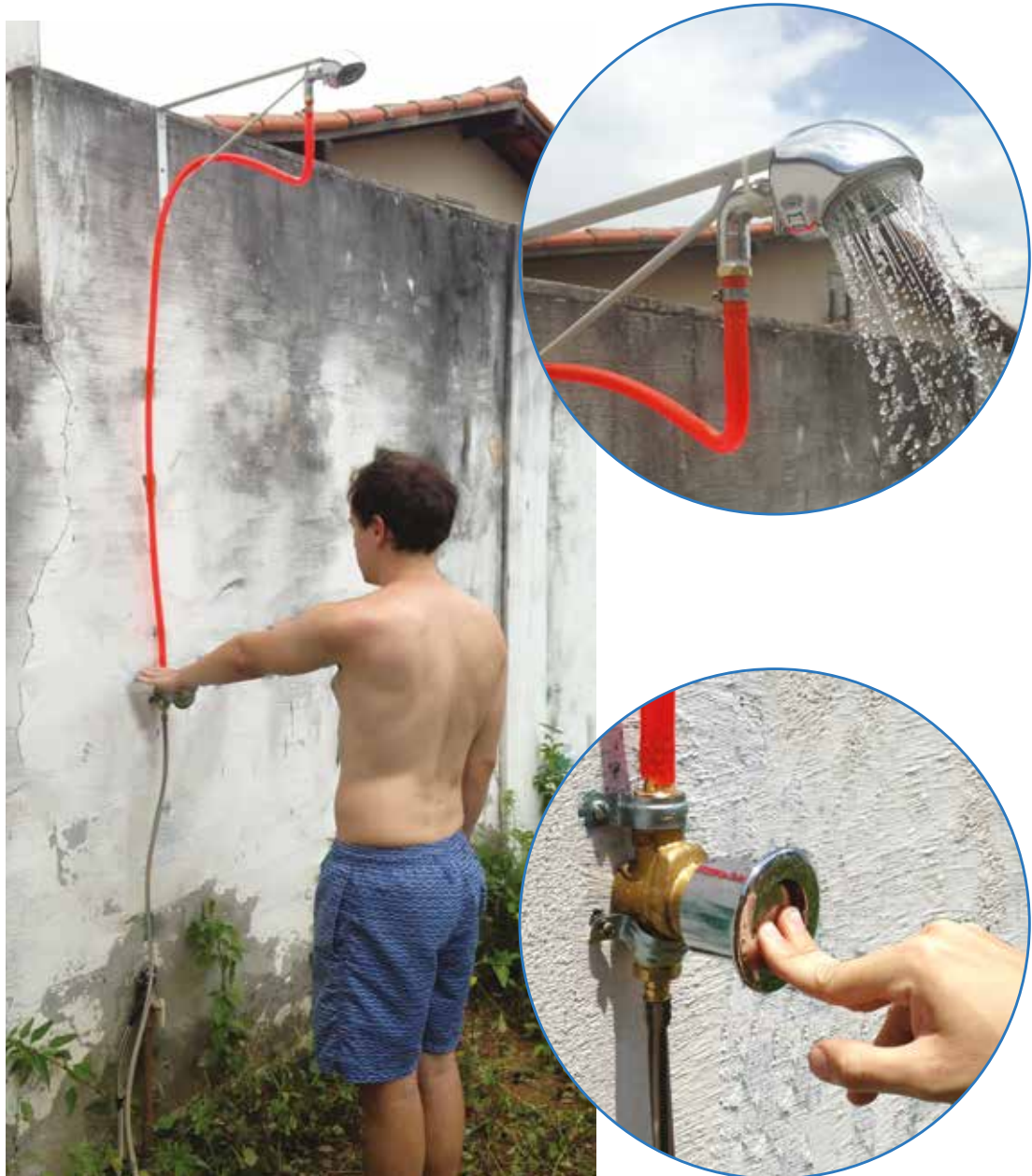
Figura 152 - Teste de acionamento do sistema. Fonte: Elaboração própria.
