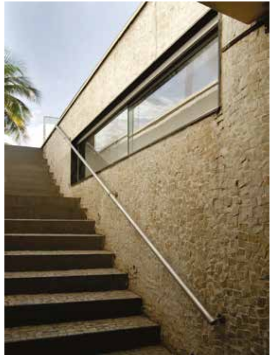
Figura 16 - Escadaria de acesso. Fonte: elaboração própria.
