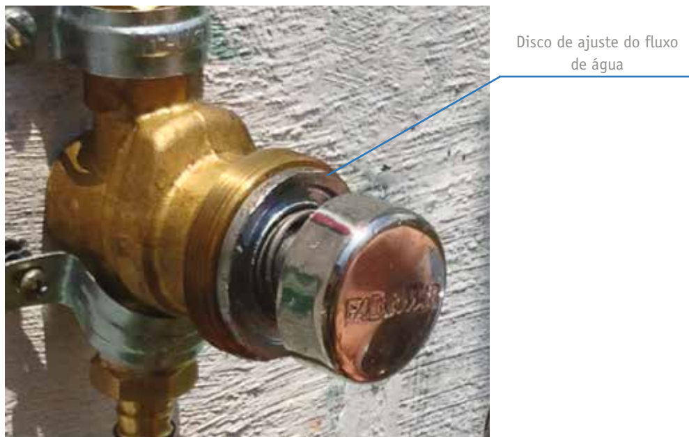
Figura 154 - Detalhe do disco de ajuste do fluxo de água. Fonte: Elaboração própria.
