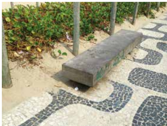
Figura 26 - Antigo banco de concreto ainda instalado no calçadão. Fonte: elaboração própria.
