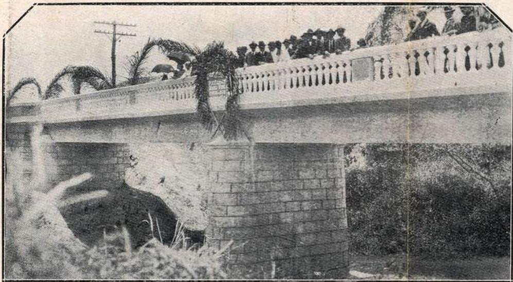
PONTE DO CAXIMBAU
