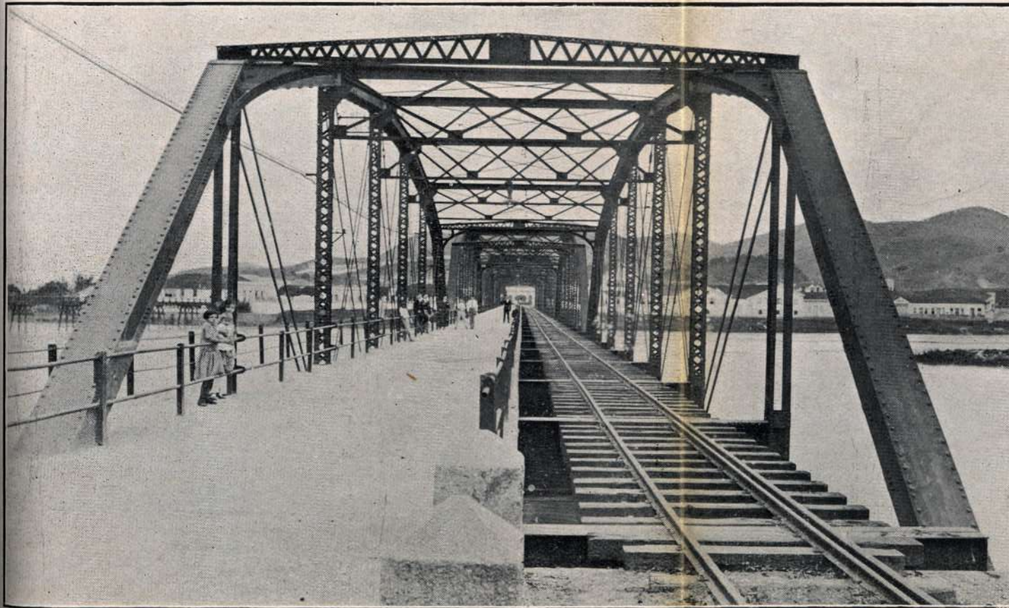
Com 12 ms. de espessura para vehiculos e pedestres. Projecto do autor. Execucao do Dr. Octavio V. Coimbra.
