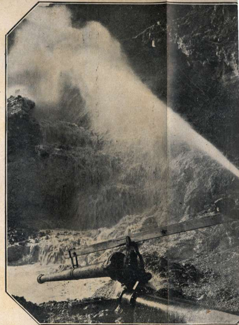
DESMONTE HYDRAULICO
