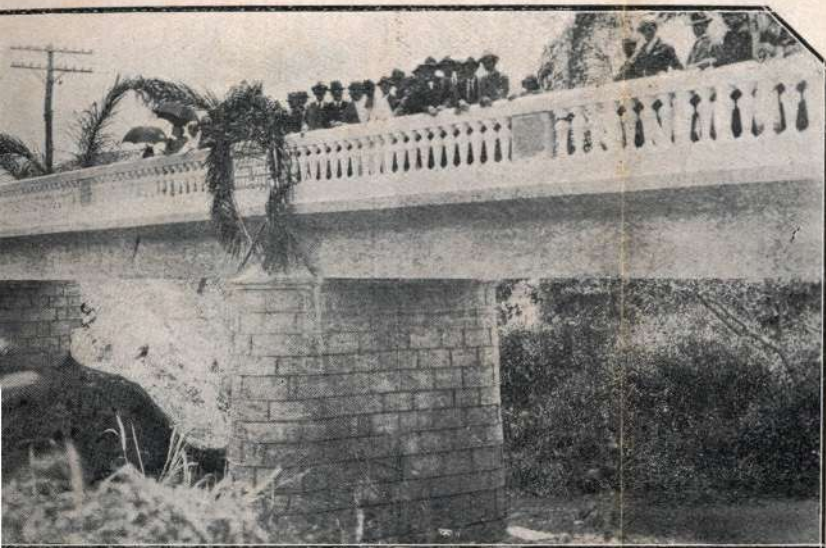
PONTE DO CAXIMBAU
