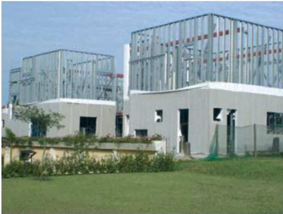
Figura 19: Aplicação de Placas Cimentícias. Fonte: VIVAN, 2011.
