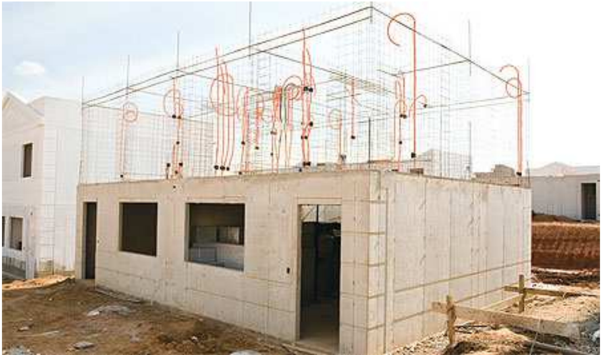
Figura 2: Construção Parede de Concreto com Fôrma de Alumínio – Fonte: http://www.revistatechne.com.br
