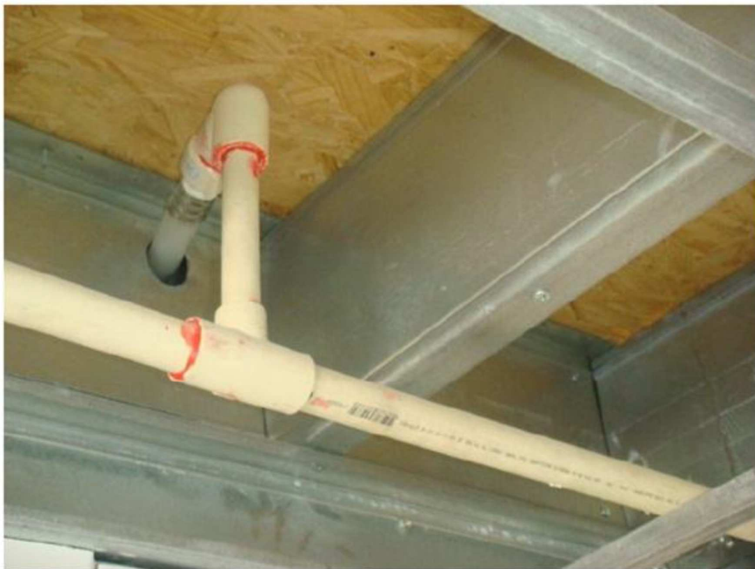
Figura 20: Furo para Passagem de Tubulação de Água Fria em LSF. Fonte: VIVAN, 2011.
