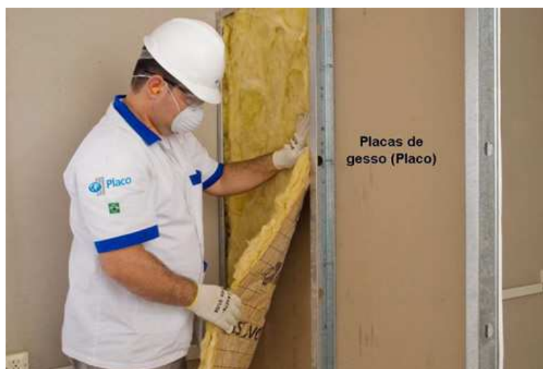
Figura 16: Aplicação Lã de Vidro. Fonte: www.pedreiro.com.br
