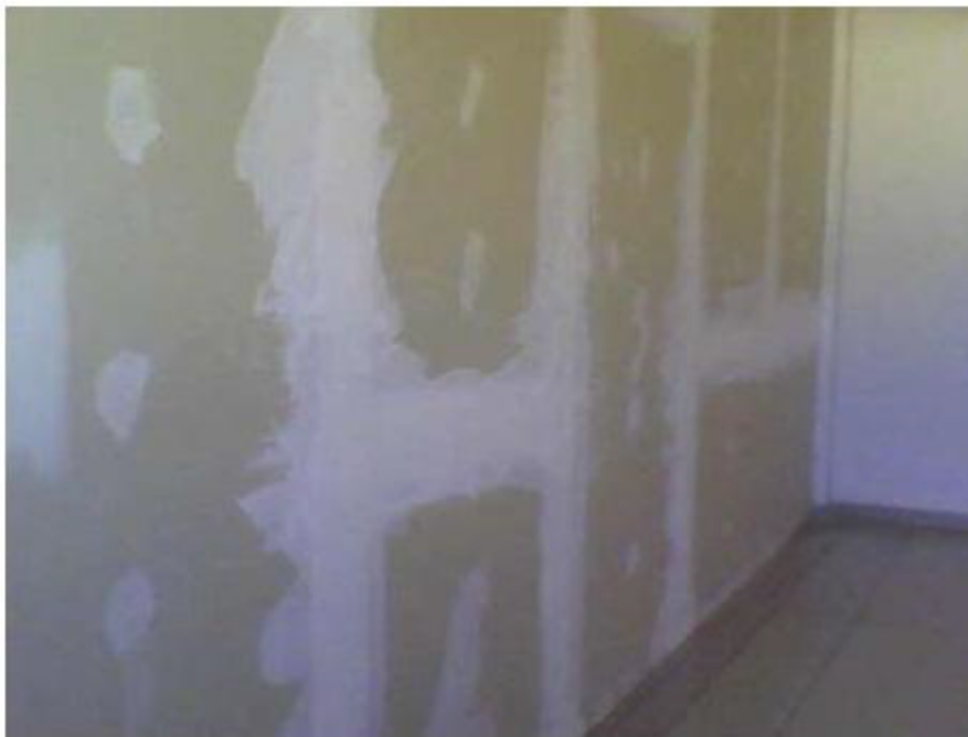
Figura 18: Fechamento em Placas de Gesso Acartonado. Fonte: VIVAN, 2011.
