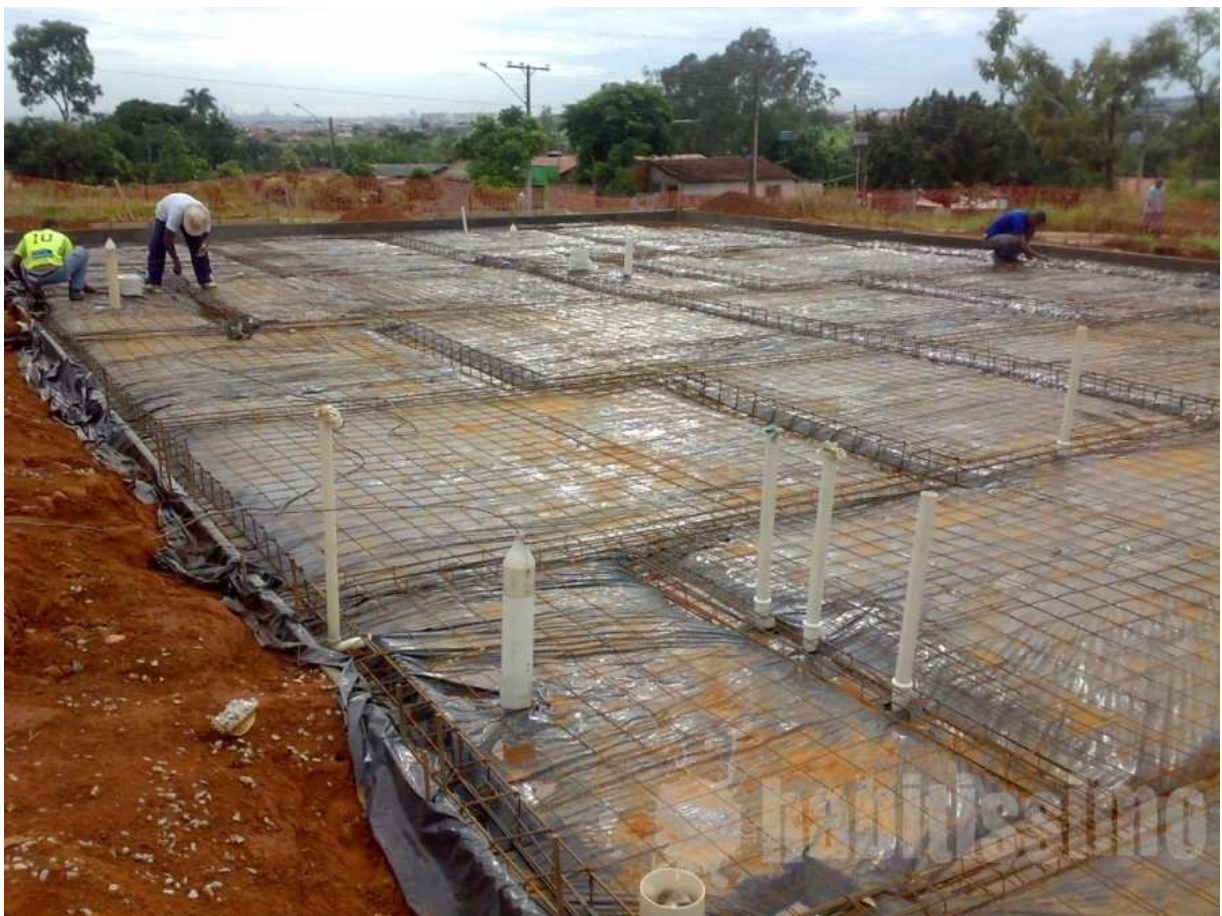
Figura 3: Forma para Radier com Armação – Fonte: http://fotos.habitissimo.com.br
