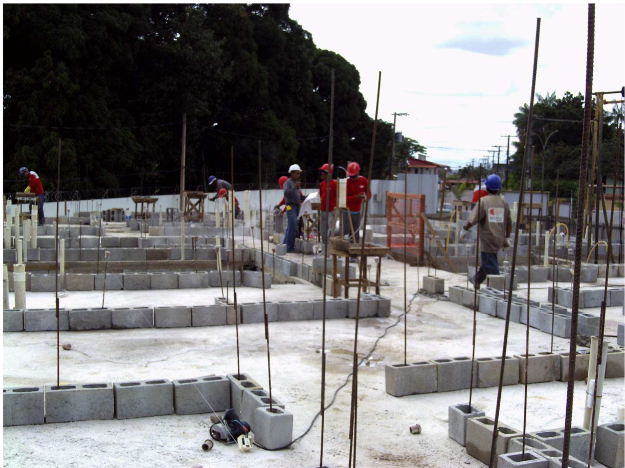
Figura 7: Marcação da Primeira Fiada em Alvenaria Estrutural. Fonte: Múltipla Engenharia, 2011.
