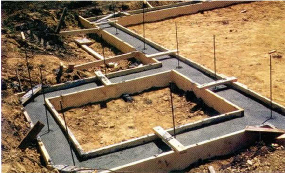
Figura 10: Fundação em Sapata Corrida. Fonte: www.lojadorevestimento.wordpress.com
