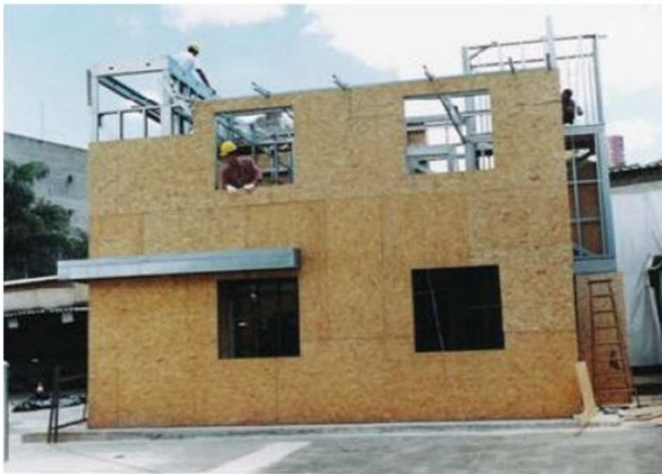
Figura 17: Aplicação de Placas OSB. Fonte: CASTRO, 2005.
