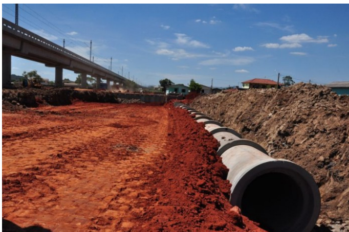
Figura 16 – Galeria Circular em Concreto
