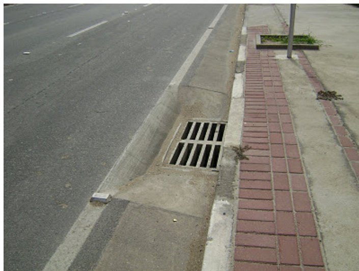
Figura 23 – Sarjeta de Concreto construída
