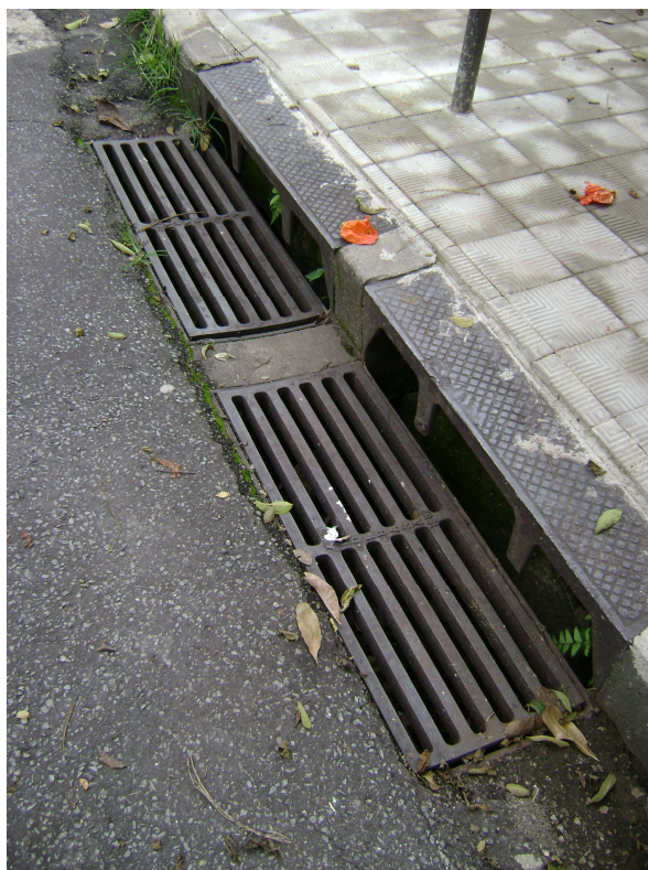
Figura 21 – Caixas de Ralo com Grelhas de Ferro fundido e bocas de lobo (Fonte: http://pt.wikipedia.org/wiki/Bueiro )
