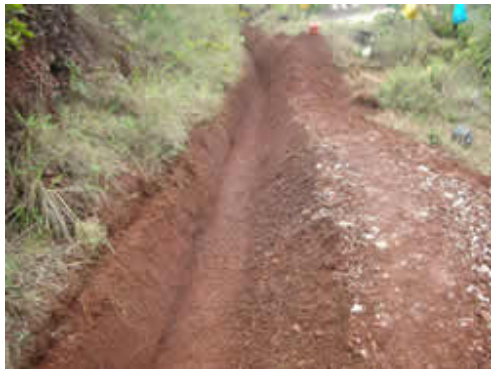
Figura 14 - Canaleta Trapezoidal em Terra (Fonte: http://www.yanterraplenagem.com.br/escadaHidraulica.html )
