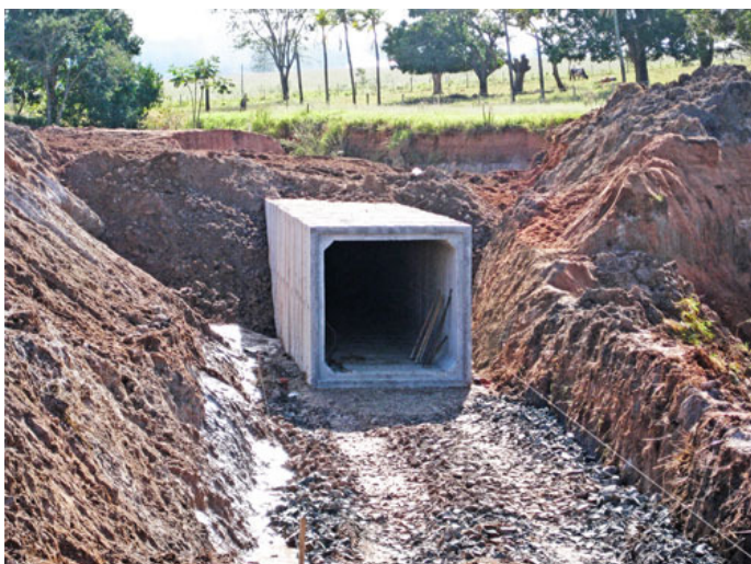
Figura 17 – Galeria Retangular em Concreto
