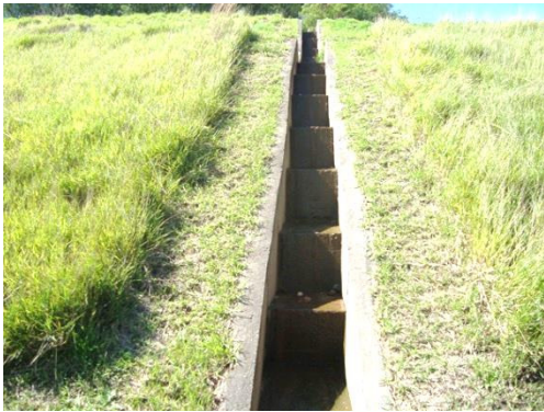
Figura 13 - Canaleta Retangular em Degraus (Fonte: http://www.terrestreengenharia.com.br/produto.asp?t=2&a=1&k=21 )
