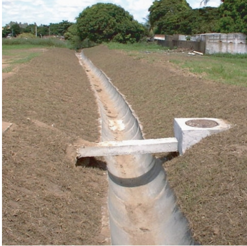
Figura 12 - Canaletas Semicirculares em Concreto (Fonte: http://www.yanterraplenagem.com.br/canaletaMeiaCana.html )
