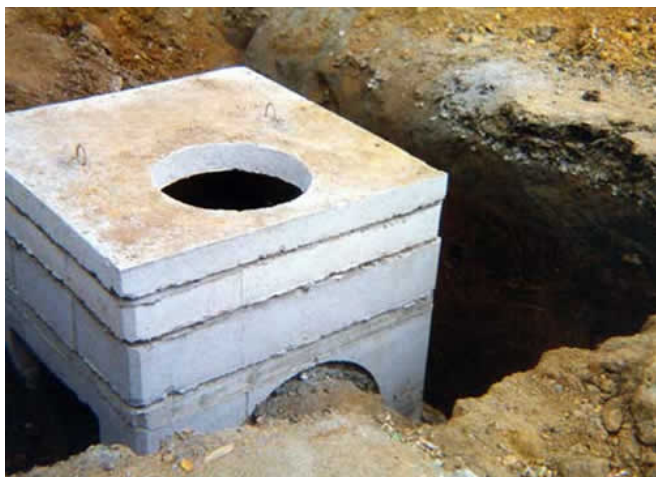
Figura 25 – PV construído cm peças pré-moldadas
