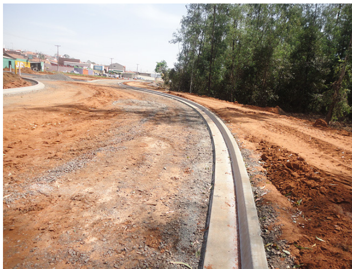
Figura 22 – Sarjeta de Concreto em construção
