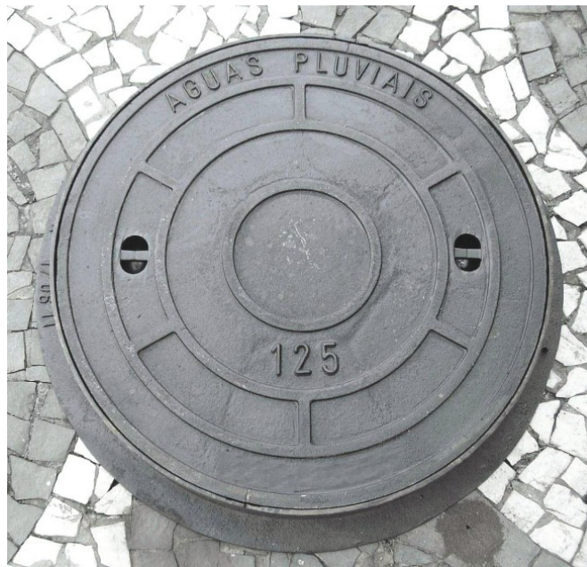
Figura 26 – Tampão de Ferro Fundido para Águas Pluviais
