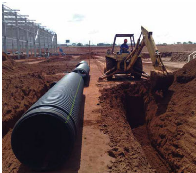
Figura 19 – Aplicação de Tubos em PEAD para Drenagem (Fonte: http://www.tigre-ads.com/br/aplicaciones.php?id_imagen=2# )
