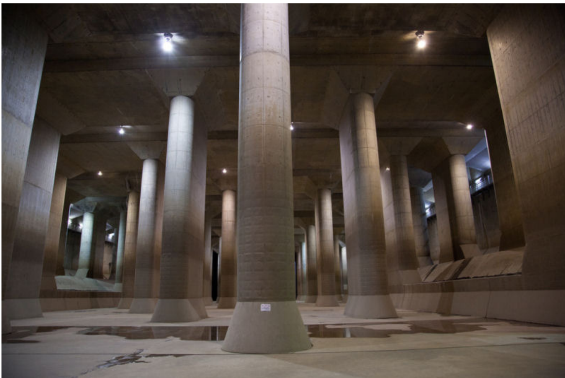
Figura 28 – Sistema de Controle de Cheias (Tóquio – Japão)
