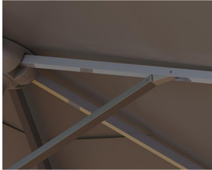
Figura IV.6 – Detalhe da Trama da Cobertura
