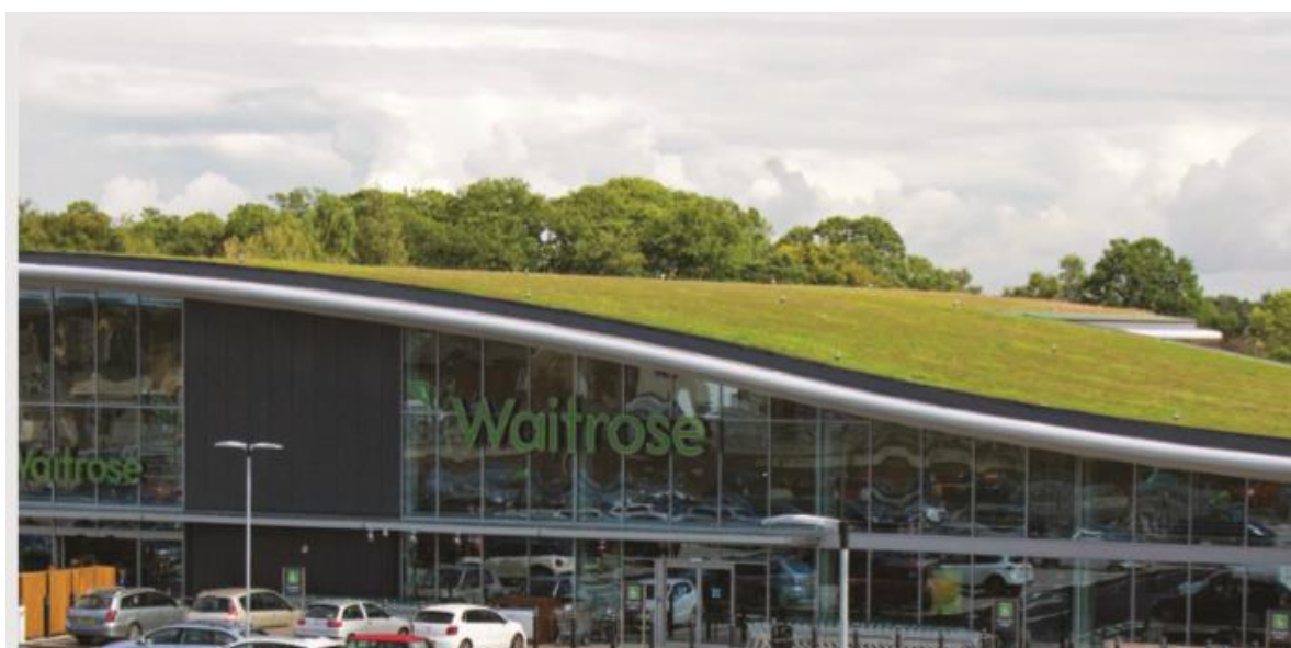
Figura 36: Cobertura extensiva com o produto Bauder Sedum Blanket.
