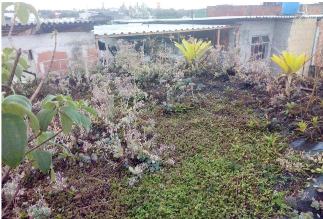
Figura 51: Sistema proposto por Bruno Rezende sobre telhas de amianto na residência de Luís Cassiano na Favela do Arará em Benfica – RJ. Elaboração própria.
