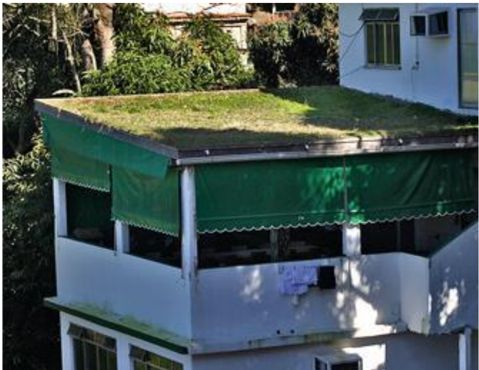
Figura 9: Telhado verde extensivo no Morro da Babilônia, RJ. Fonte: https://ecotelhado.com/telhado-verde-chega-tambem-aos-morros-cariocas/ (Acessado em 08/09/2018).
