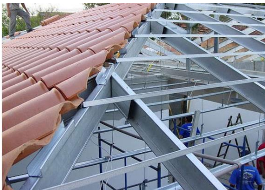
Figura 323: Corte de telhas no espigão geralmente realizado com uma serra de corte elétrica (Makita).
