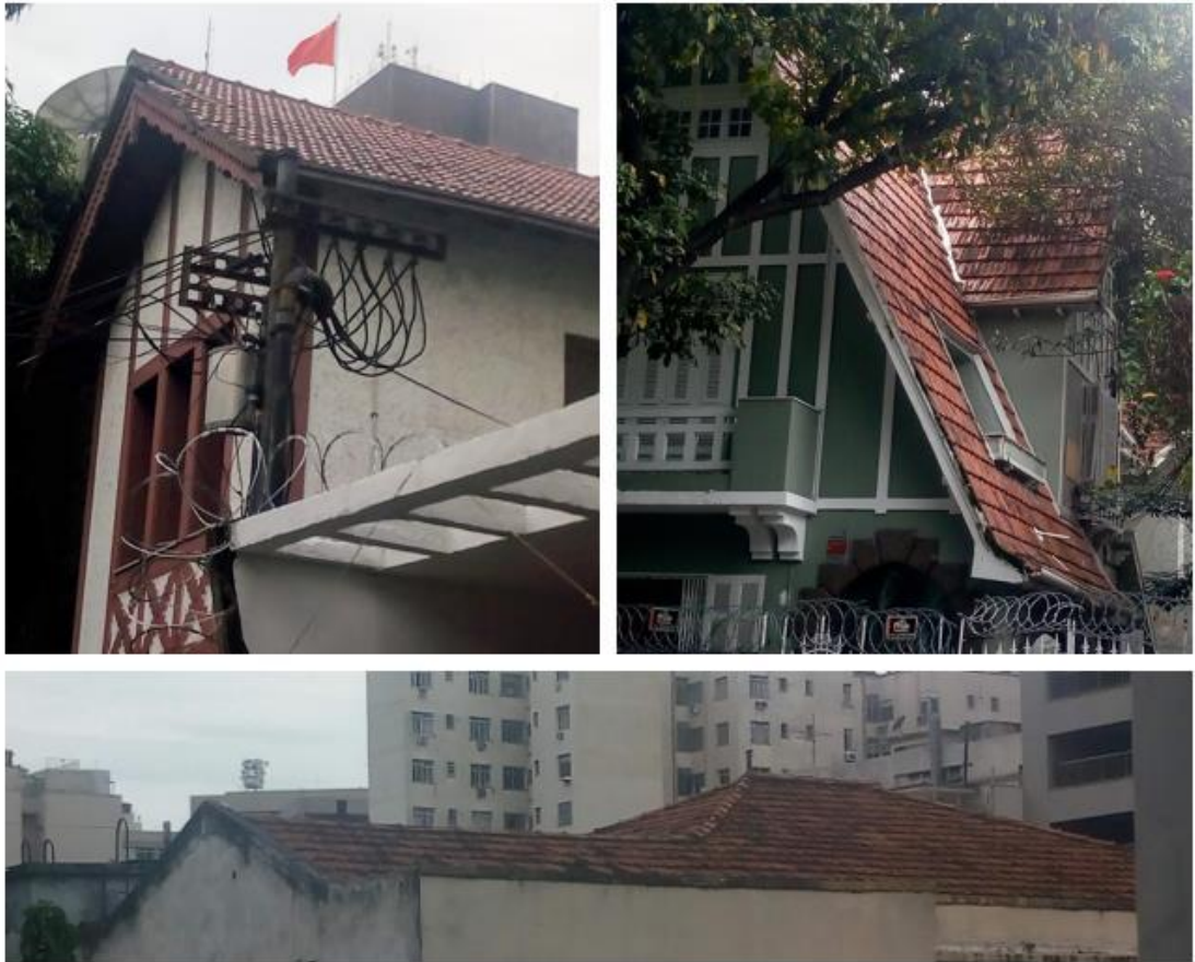
Figura 23: Vista de telhados com diferentes inclinações em Botafogo - RJ. Elaboração própria.
