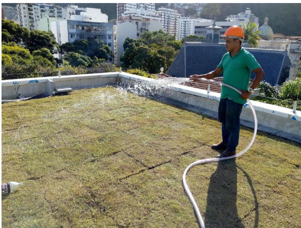
Figura 44: Aplicação do sistema Alveolar Médio da Ecotelhado. Elaboração própria. Foto tirada no Edifício Firjan RJ, em Botafogo – RJ. Elaboração própria.
