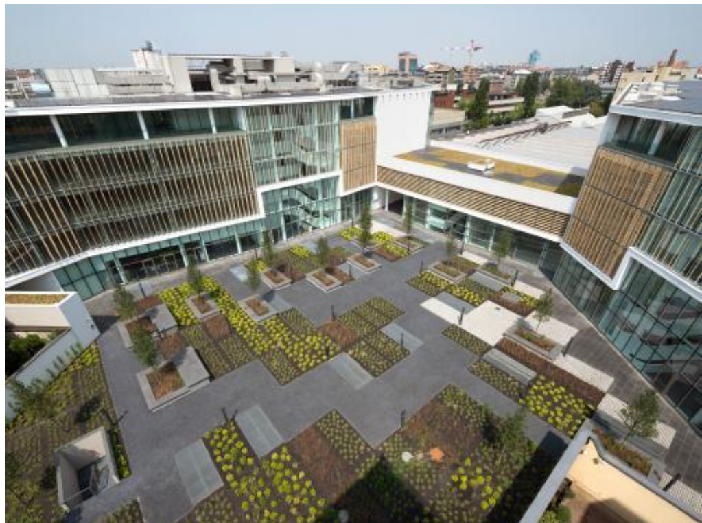
Figura 41: Cobertura extensiva com o produto ZinCo Sedum Carpet.
