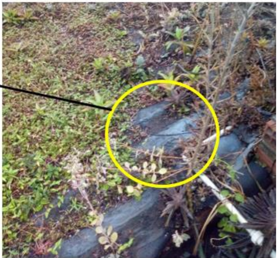
Figura 85: Falhas no recobrimento vegetal no telhado de Luís Cassiano utilizando a técnica de Bruno Rezende. Elaboração própria.
