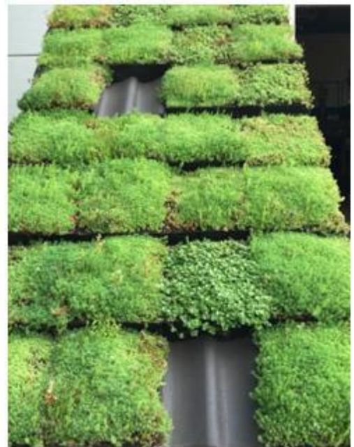
Figura 47: Imagens do modelo e instalação da Groendakpan, telha desenvolvida pela empresa Groendak. Fonte: Groendakpan.nl.
