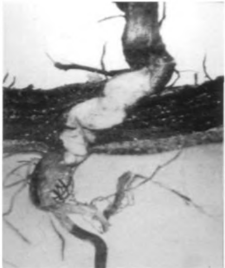
4.5 Perforación producida por raíces de cardos en una membrana asfáltica de cerca de 15mm de espesor, después de 15 meses de duración del ensayo (Pennigfeld et al. 1981)
