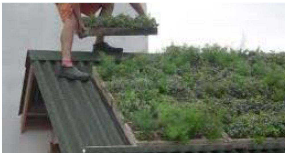
Figura 45: Sistema modular não mais produzido pela empresa Ecotelhado, feito com bandejas de borrachas reciclada, pode ser aplicado diretamente sobre telhas. Fonte:www.ecotelhado.com. (Acessado em 18/09/2018)
