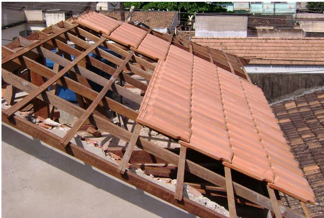
Figura 26: Engradamento de madeira. Fonte: https://pselshadai.webnode.com.br/serviços/ (Acessada em 02/09/2018).
