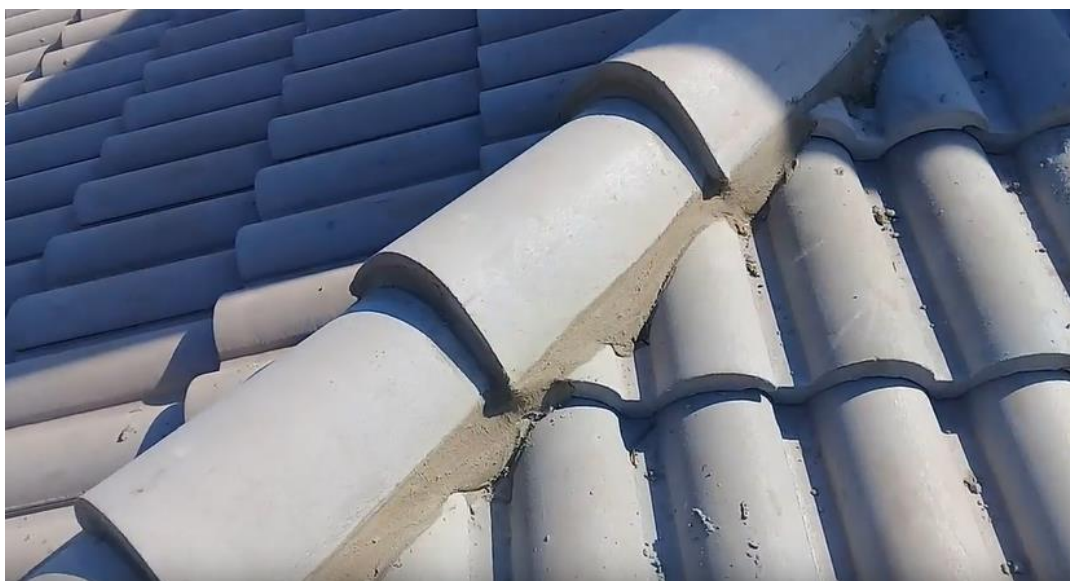
Figura 332: Acabamento com embolso de cimento no espigão. Fonte: https://www.youtube.com/watch?v=NtVy8CVtQ0c . (Acessado em 8/10/2018).
