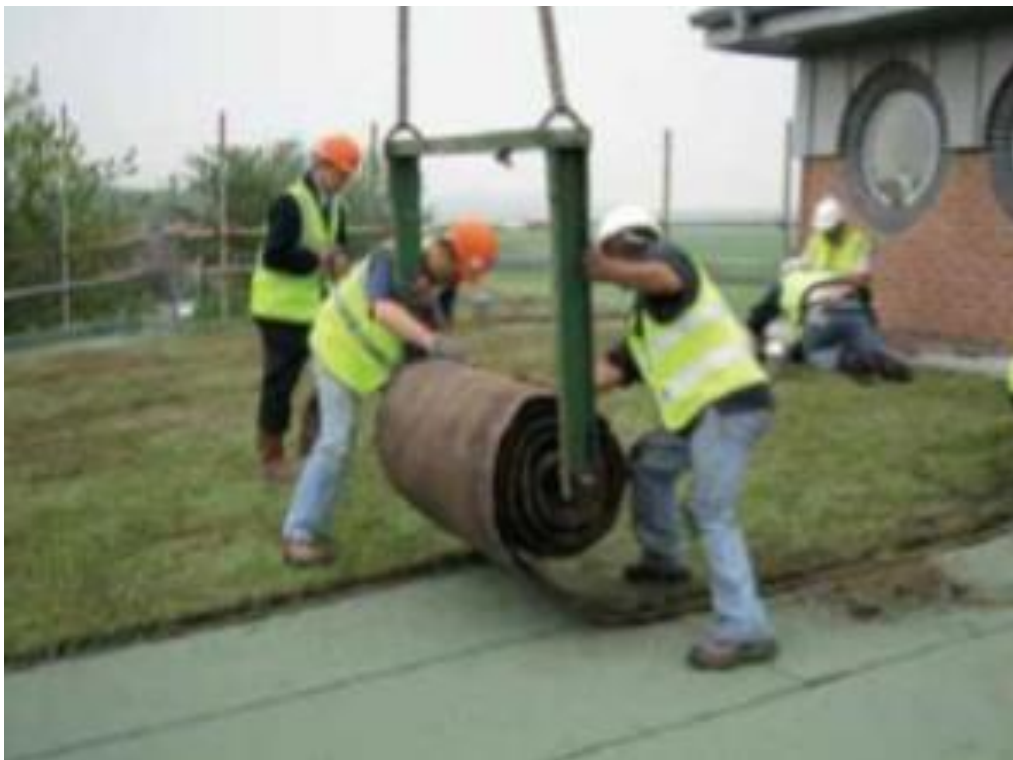
Figura 37: Instalação dos rolos pré vegetados com auxílio de guindastes.
