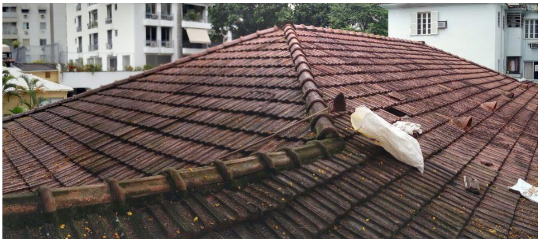
Figura 24: Telhado com várias águas, em Botafogo – RJ. Fonte: Foto: Rafael Aguirre.
