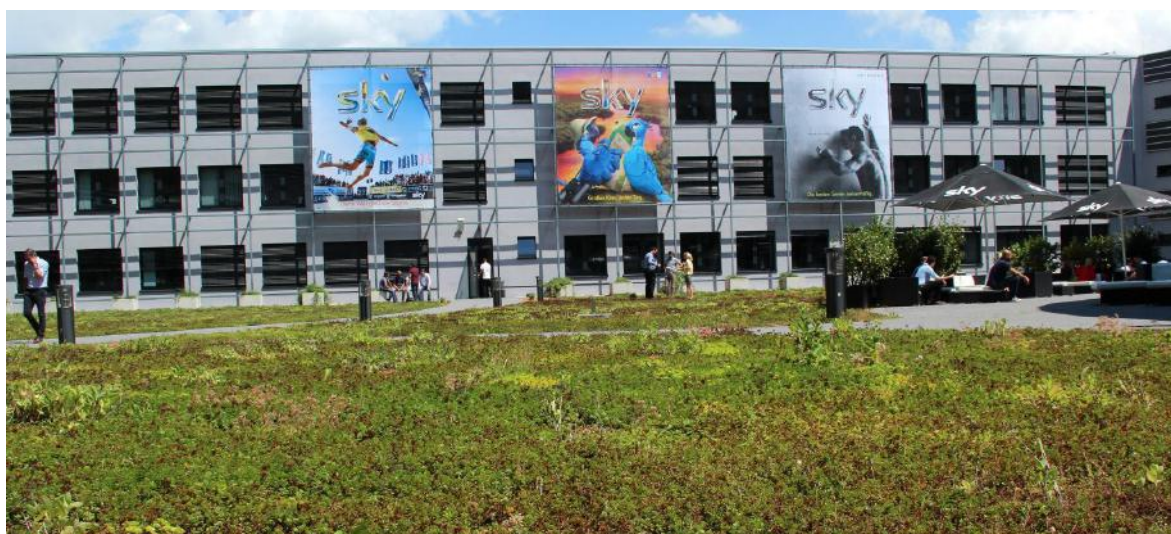
Figura 39: Cobertura extensiva com o produto ZinCo Sedum Carpet. Terminal Building, Airport Ibiza/Spain.
