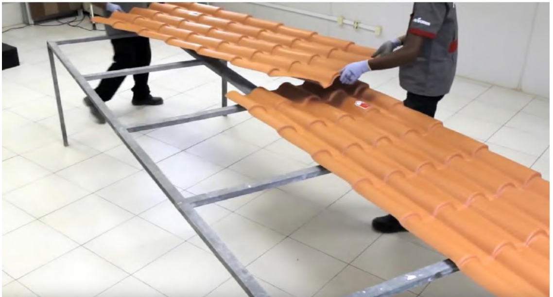
Figura 122: Montagem das telhas de PVC.
