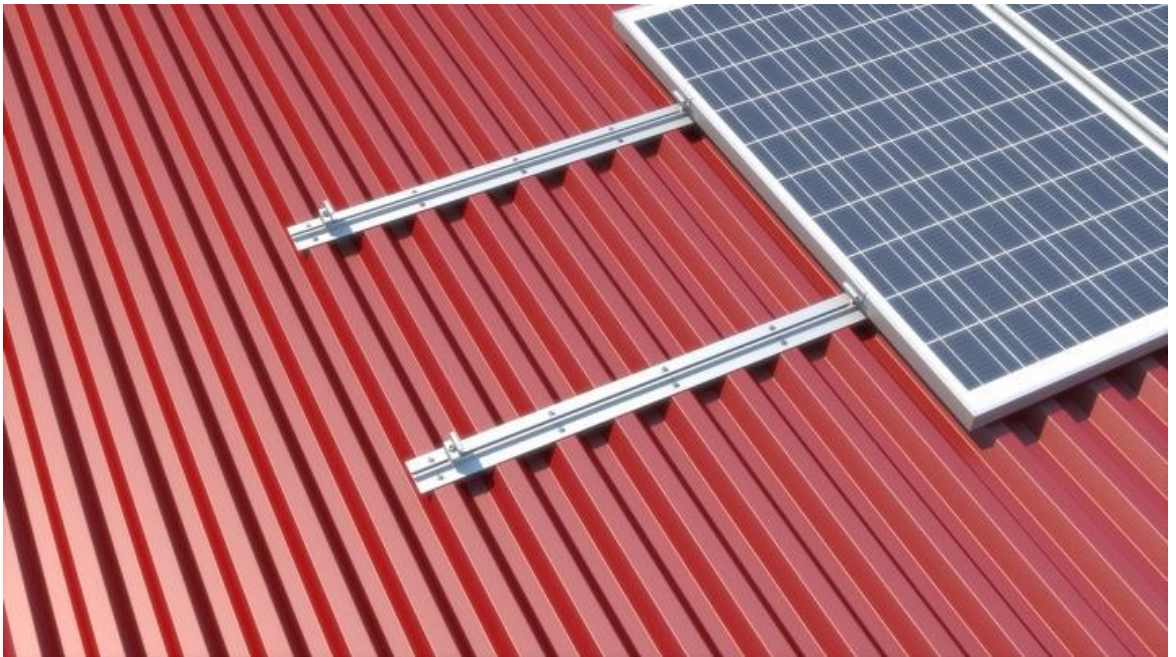
Figura 106: Instalação de painel solar sobre telha trapezoidal. Fonte: http://remorsolar.com/wp-content/themes/remor/pdf/en/Slopedroofs.pdf (Acessado em 24/11/2018).
