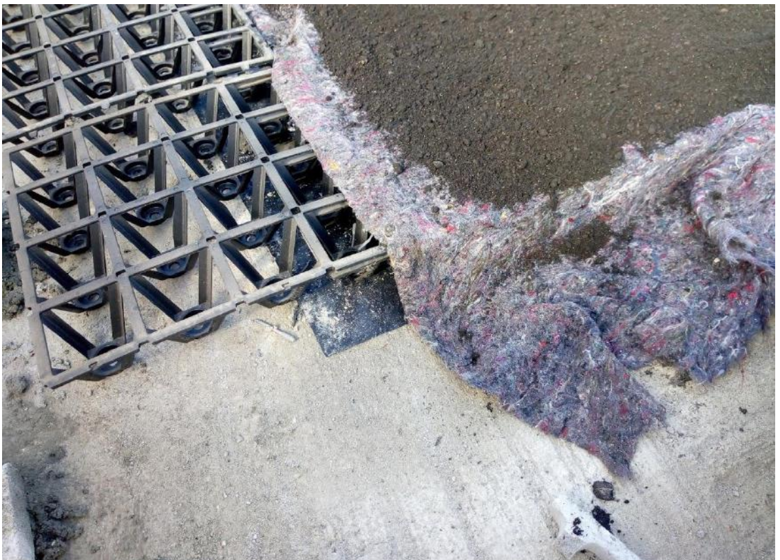
Figura 43: Camadas do sistema Alveolar Médio da Ecotelhado. Foto tirada no Edifício Firjan RJ, em Botafogo – RJ. Elaboração própria.
