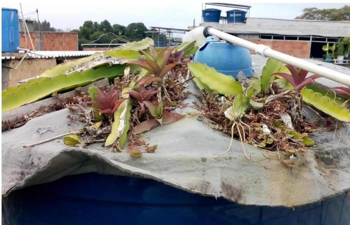
Figura 55: Uma das vertentes da parceria entre Bruno Rezende, Luís Cassiano e a Equipe Teto Verde da Enactus UFRJ, foi a aplicação de cobertura vegetal diretamente sobre o Bidim RT 16 em caixas d'água para atenuar a temperatura da água nos dias de calor no Rio de Janeiro. Elaboração própria.
