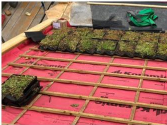
Figura 47: Imagens do modelo e instalação da Groendakpan, telha desenvolvida pela empresa Groendak. Fonte: Groendakpan.nl.
