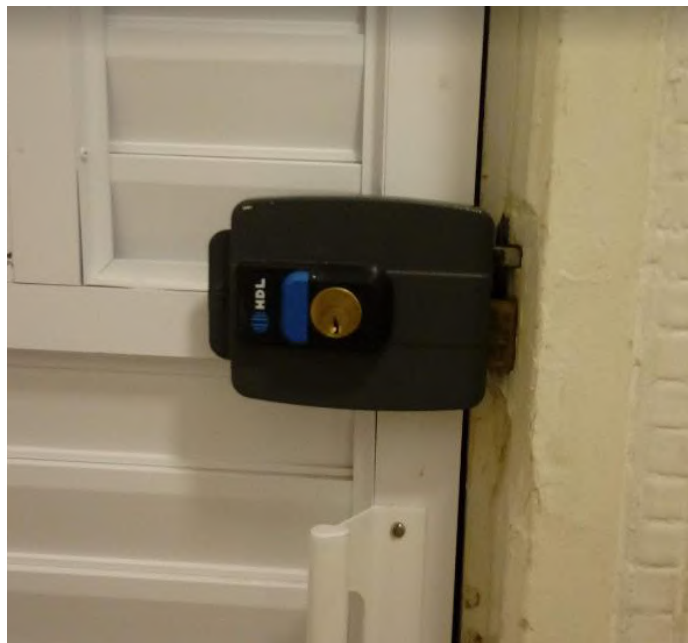
Figura 24: Exemplo de fechadura de sobrepor instalada em porta de alumínio. Abaixo da fechadura, foi fixado um puxador em cada lado da folha. Elaboração própria.
