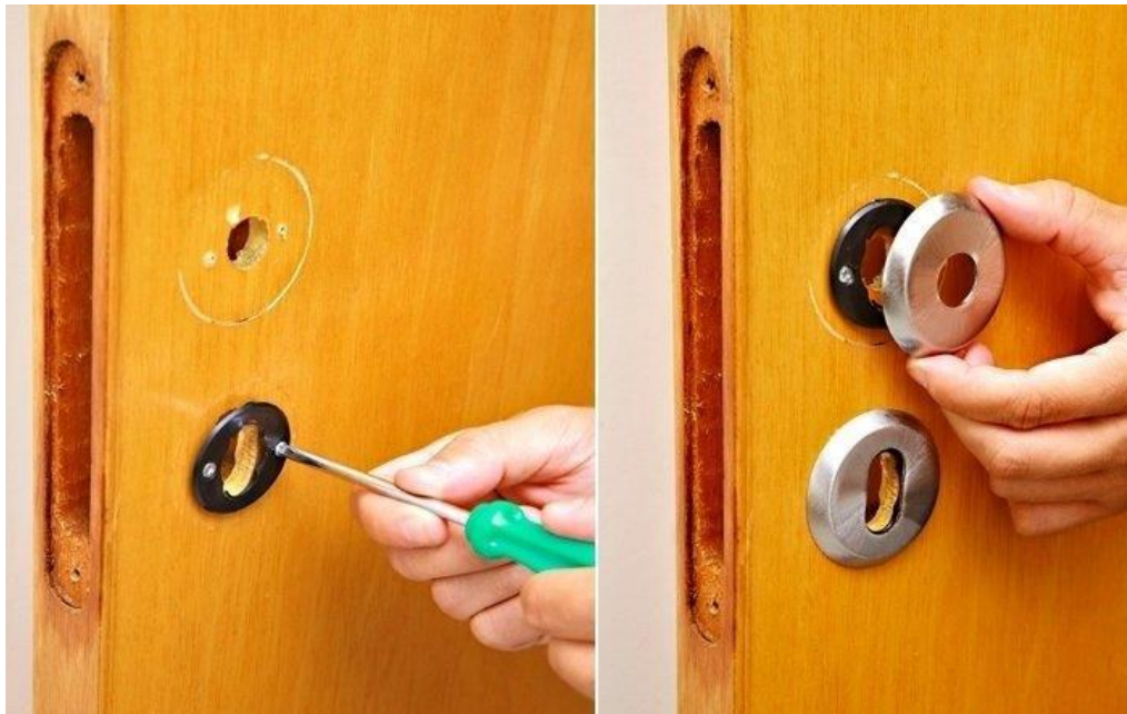
Figura 110: Exemplo do sistema de fixação de rosetas replicado no produto desenvolvido. Retirado do site: https://www.getninjas.com.br/guia/reformas-e-reparos/marido-de-aluguel/como-trocar-fechadura/ (acesso em novembro de 2018).
