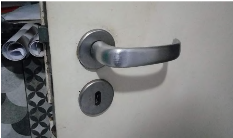
Figura 25: Exemplo de fechadura de embutir (para portas internas) instalada numa porta de madeira. Elaboração própria.
