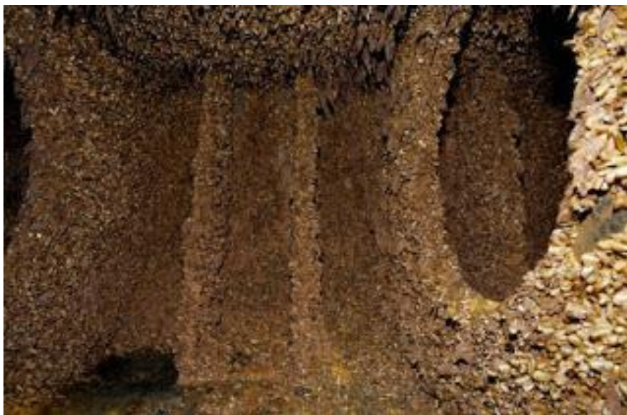
FIGURA 5. Mexilhões dourados se proliferam em estruturas metálicas submersas da usina de Itaipu. (Adaptado de https://zonaderisco.blogspot.com.br/2016/12/mexilhao-dourado-invade-o-nordeste.html )
