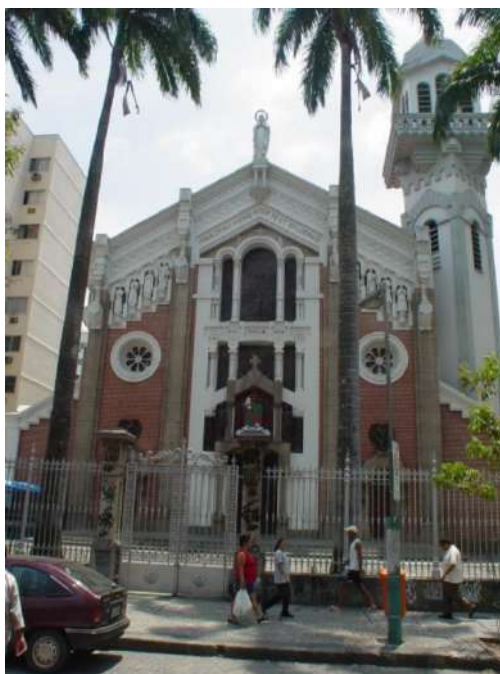
Figura 3 - Fachada da Basílica Nossa Senhora de Lourdes.
