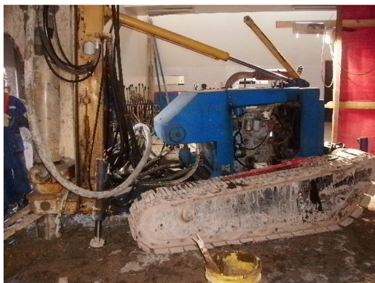
Figura 5.2: Perfuratriz munida de revestimento, utilizada na execução da estaca raiz
