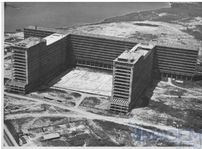
Foto 3.3: Obra do Hospital Universitário durante a construção (UFRJ, 2013)
