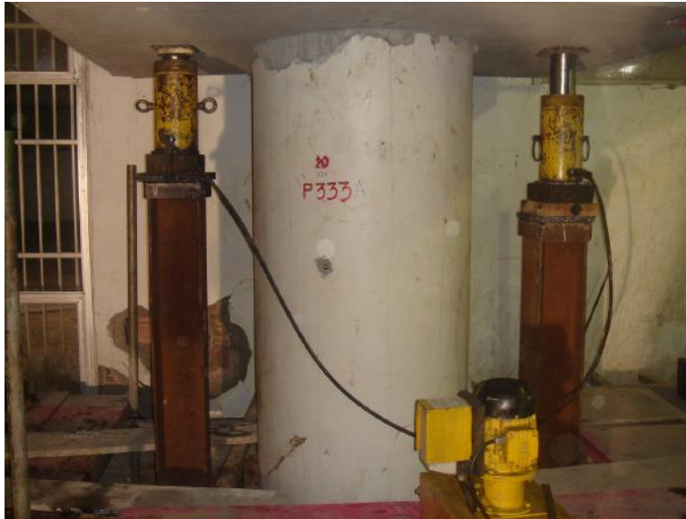
Figura 5.7: Execução das Estacas tipo Mega
