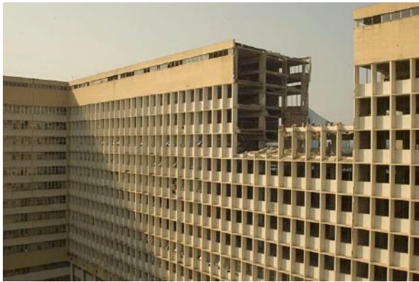
Figura 3.6: Demolição manual, a fim de separar área a ser implodida (UFRJ, 2013)
