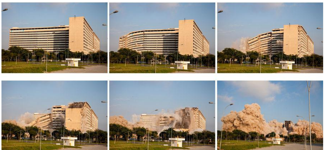
Figura 3.7: Implosão da Ala Sul do HUCFF
