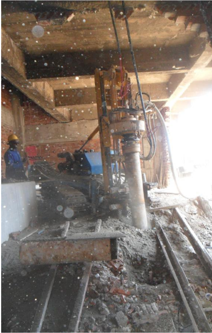
Figura 2.2: Estaca raiz sendo executada, ilustrando a sujeira da obra
