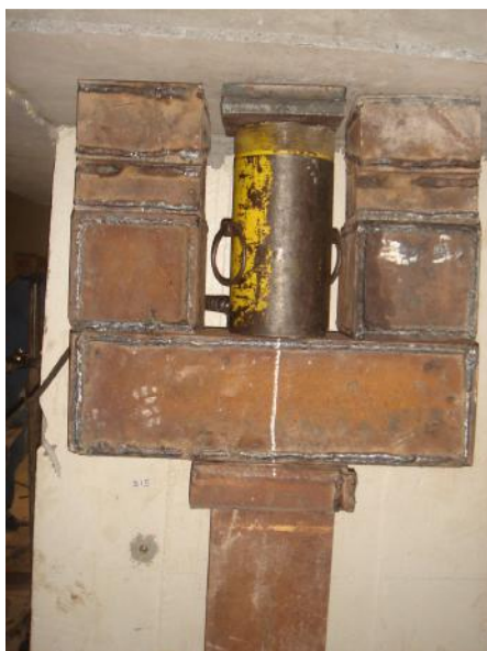
Figura 5.9: Estaca metálica depois de executado o encunhamento
