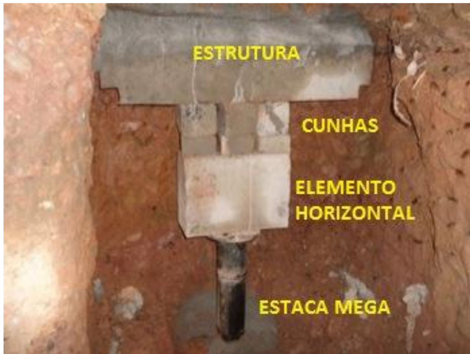
Figura 2.2: Estaca tipo Mega pronta no Edifício Victoria em Pirituba/SP (INDAMEGA, 2013)
