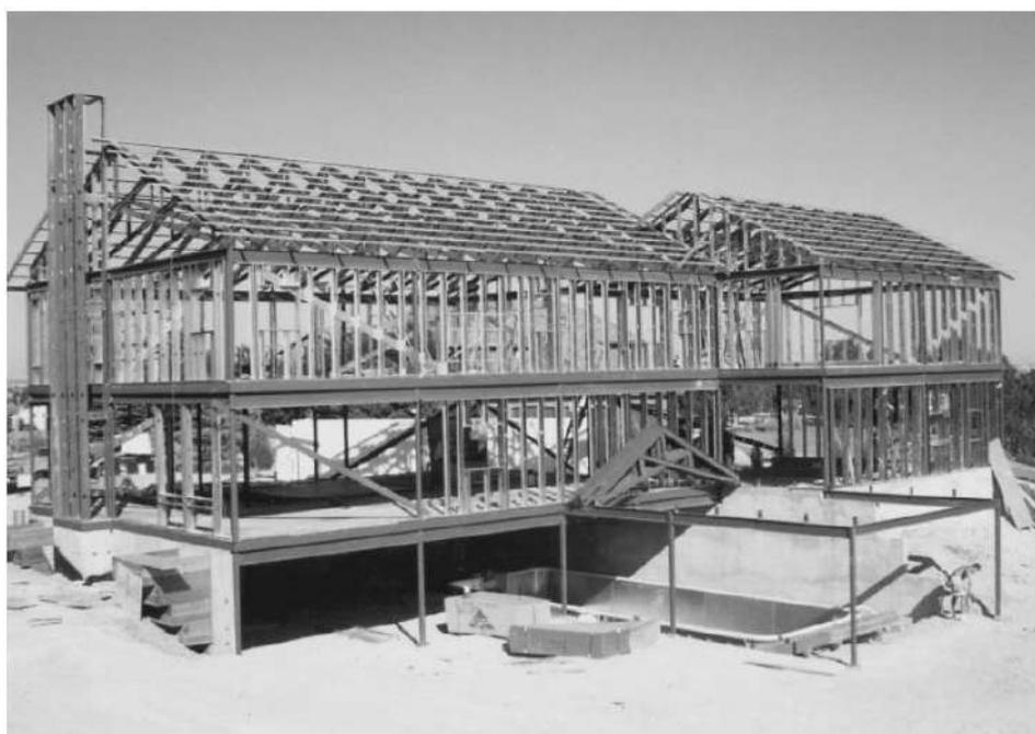
Figura 1.1 – Construção de uma residência em perfil formado a frio (YU, 2000).
