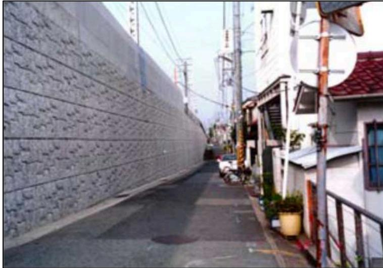
Figura 2.6. Muro de solo reforçado com geogrelha com face rígida em Tanata, Japão - Fotografia imediatamente após construção, 8 de julho de 1992 (Tatsuoka *et al.*, 2007).
