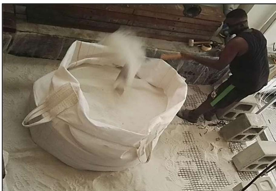
Figura 3.5. Remoção manual da areia no processo de desmontagem dos muros.
