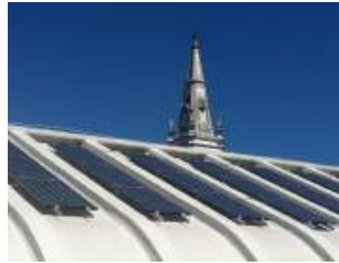
Figura 5 – Usina de geração de energia
