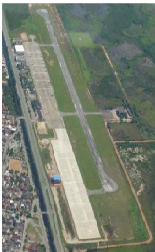
Figura 7 – Ampliação do pátio de aeronaves do Aeroporto de Macaé
