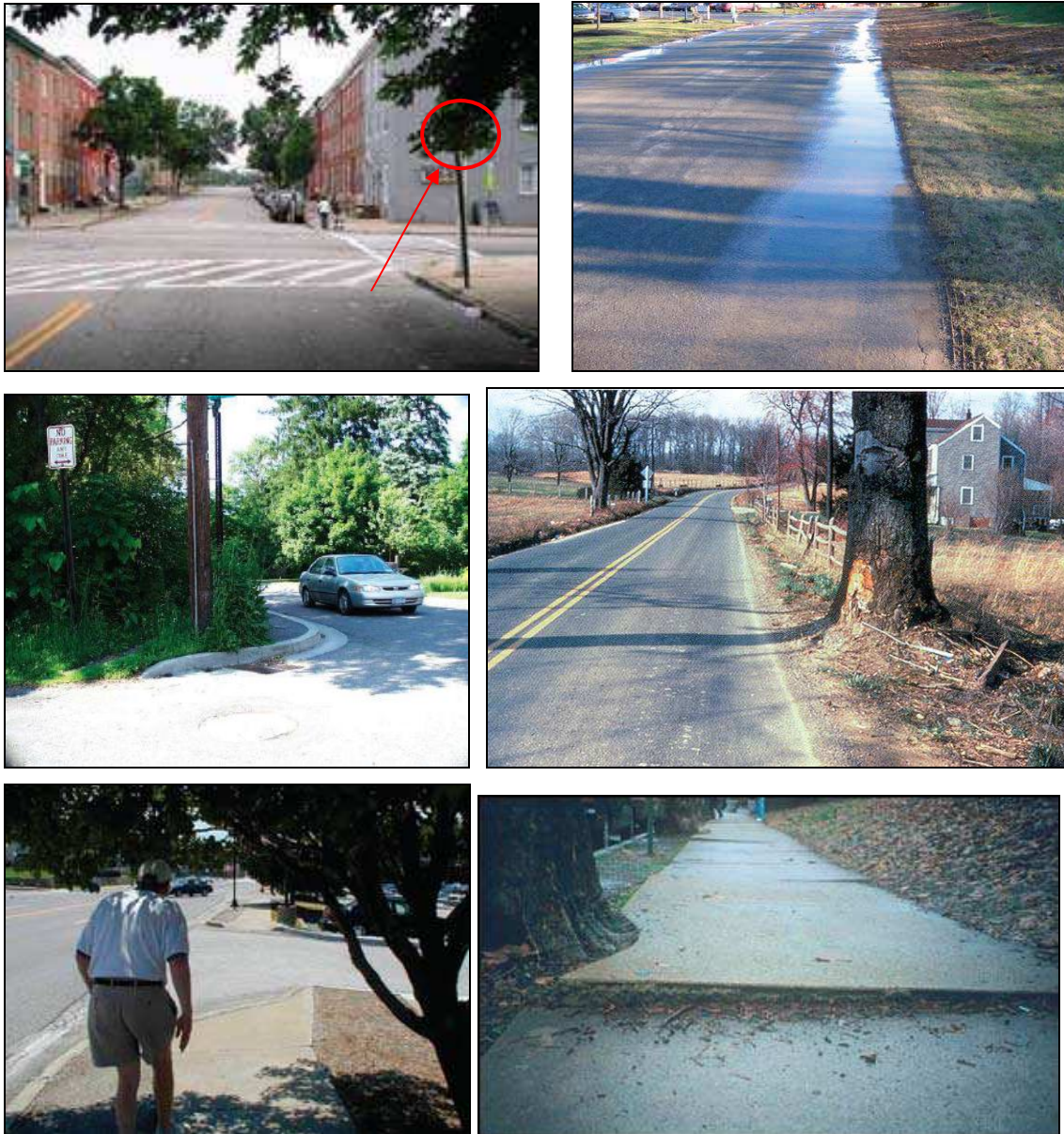
Figura 3.20: Problemas originados pela falta de controle da vegetação. Fonte: FHWA (2008).
