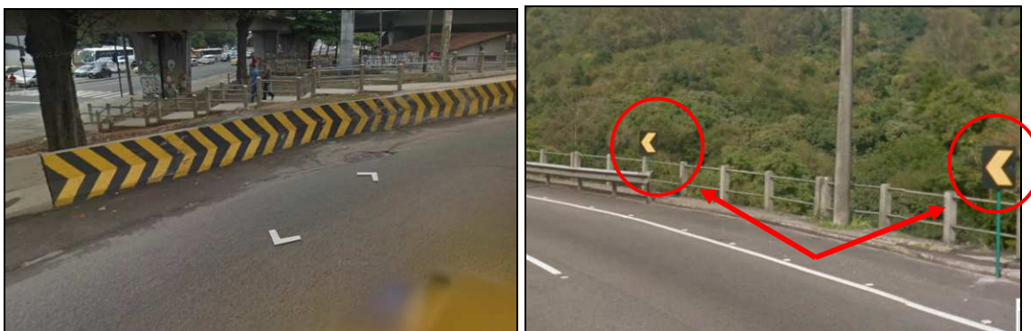
Figura 3.7: Exemplos de canalizadores e delineadores.
