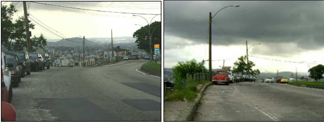
Figura 4.27: Superelevação Invertida e presença de veículos estacionados no acostamento.
