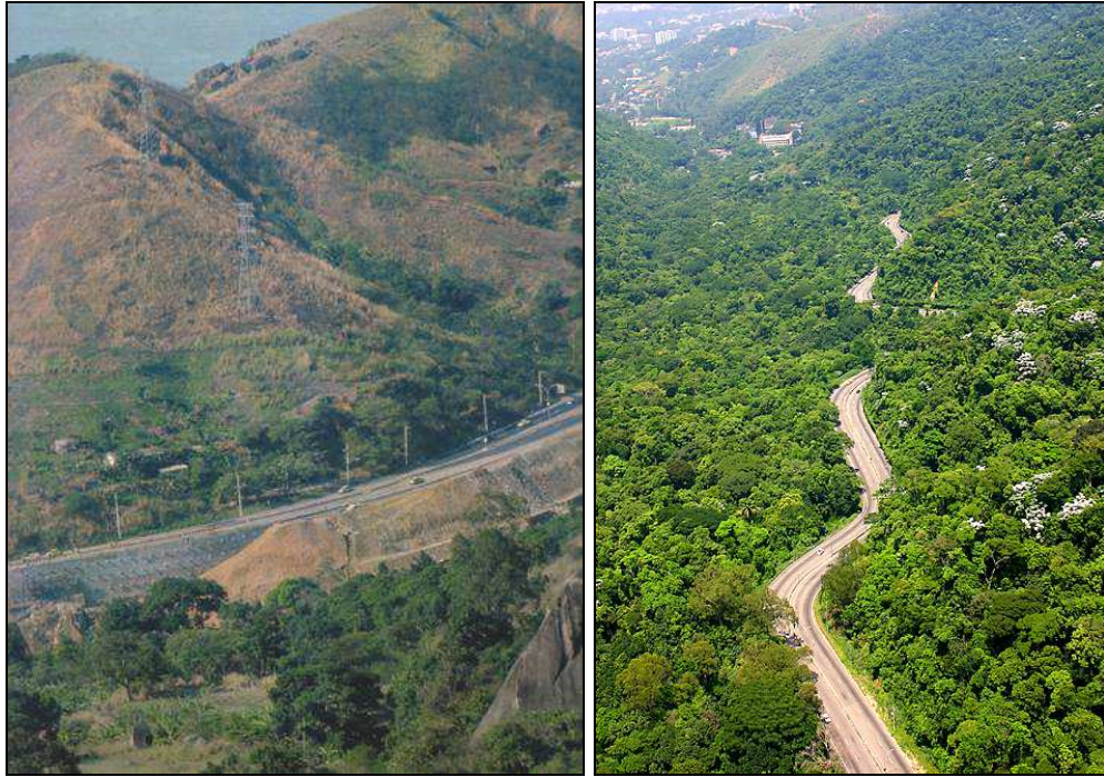
Figura 4.2: (a) Vista da Estrada Grajaú-Jacarepaguá (esquerda) e (b) Vista de parte de seu traçado (direita) após a obra de duplicação.
