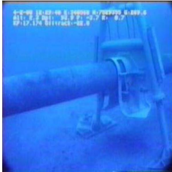
Figura 11 - Exemplo de Suporte Mecânico Instalado ao Duto, [7]
