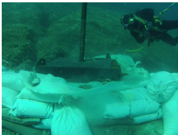
Figura 9 – Exemplo de Instalação dos Grout Bags, [6]
