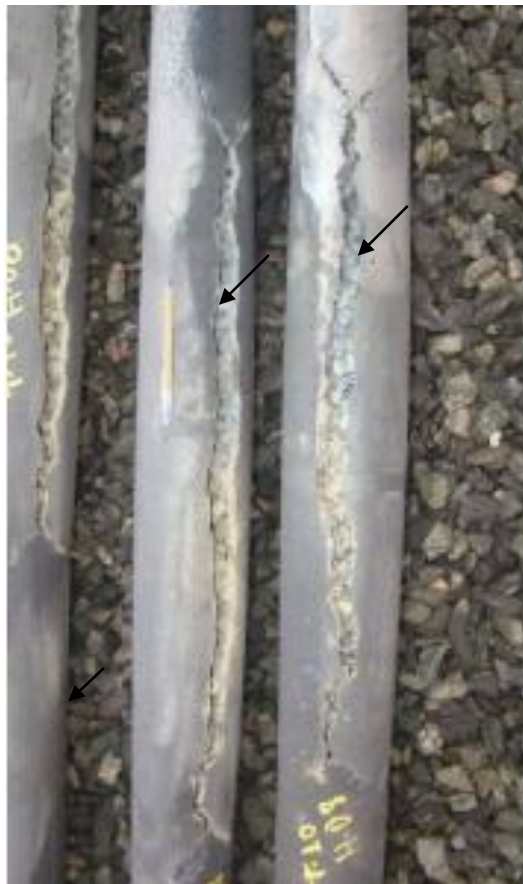
Figura 3.2 - Tubos do forno de reforma após falha de operação por surto de temperatura com a presença de trincas e ramificações das mesmas [9].
