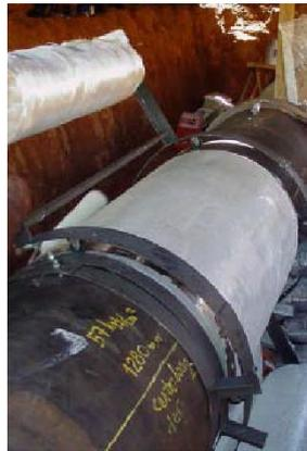
Figura 4: Manta de material compósito para aplicação de resina [3] [4]
