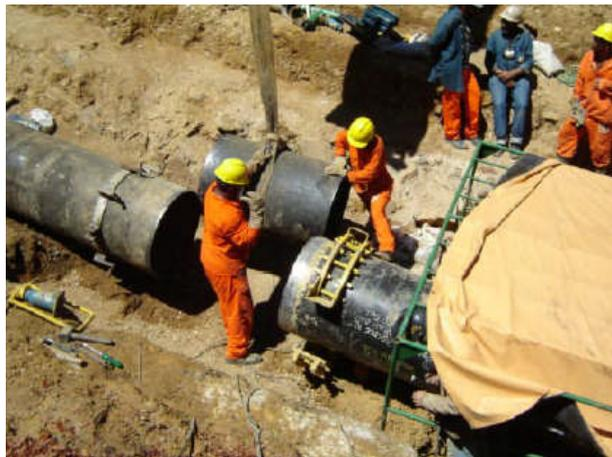
Figura 1: Troca de trecho de tubulação danificado por segmento novo [3] [4]
