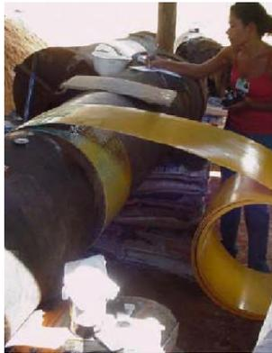
Figura 5: Aplicação direta de placa de compósitos [4]
