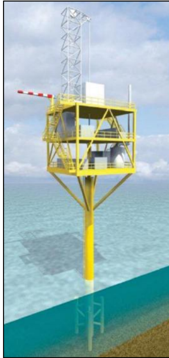
Figura 63. Ilustração de uma plataforma que é instalada individualmente acima de cada caverna
