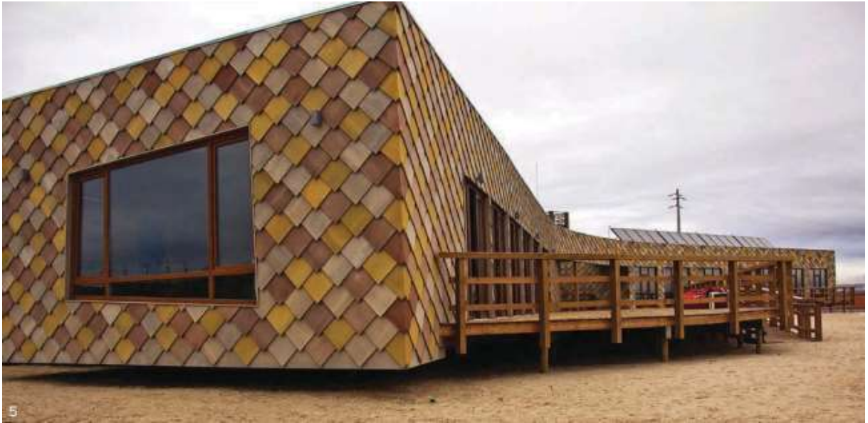
Figura 7 - Viroc® aplicado à fachada do Centro de Alto Rendimento de Surf de Peniche (fonte: Dossiê Técnico Viroc®)
