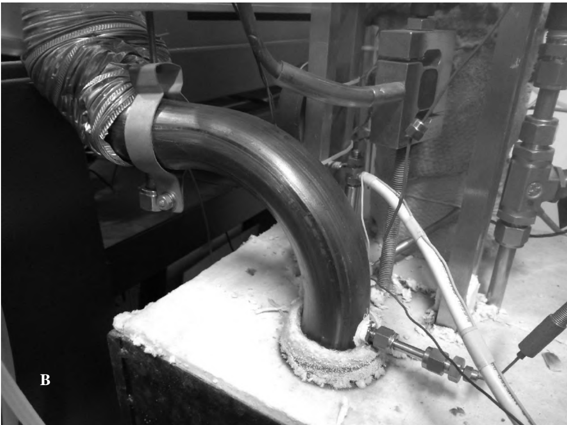
Figura 59 - Montagem: finalização do isolamento térmico (A); duto de exaustão (B).
