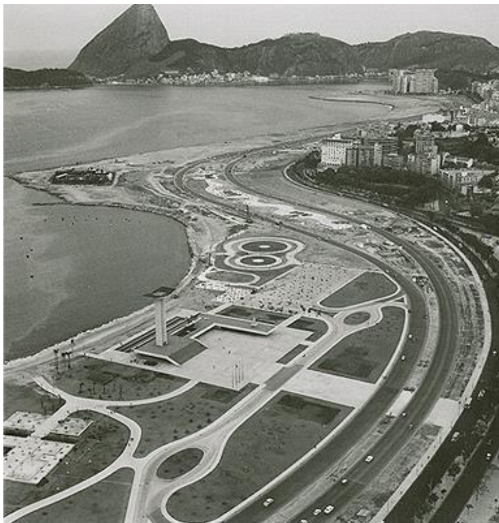
Figura 11 - Vista aérea da construção do Parque do Flamengo.
