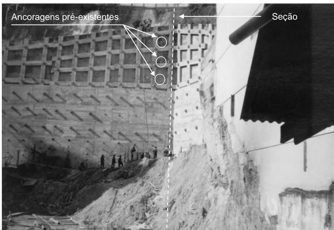
Figura 4.70 - Foto da Ocorrência 3 mostrando as ancoragens pré-existentes.
