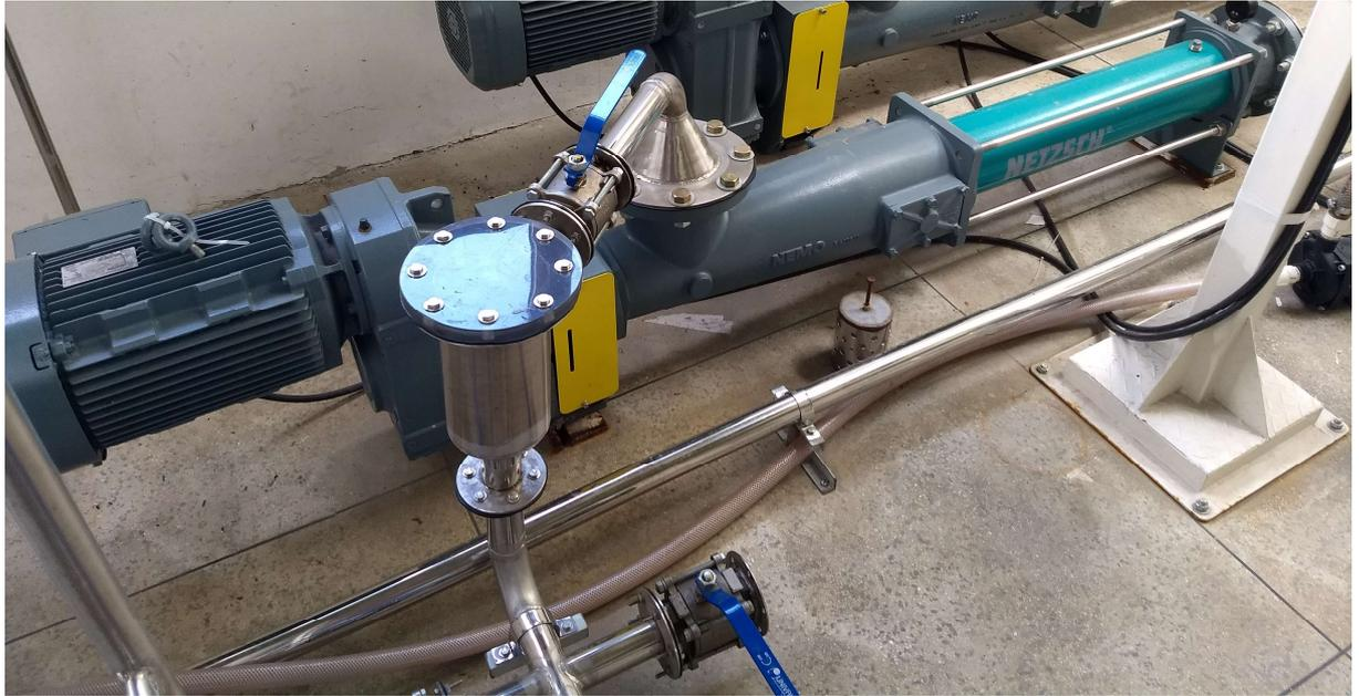
Figura 3.17: Bombas de suprimento de líquido e de retorno do tanque de captação
