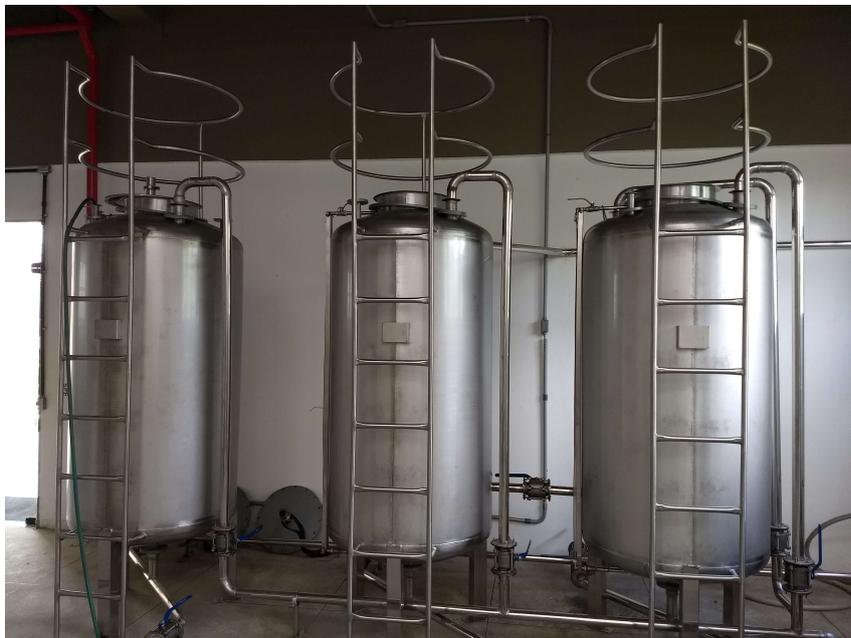
Figura 3.12: Tanques de suprimento de água
