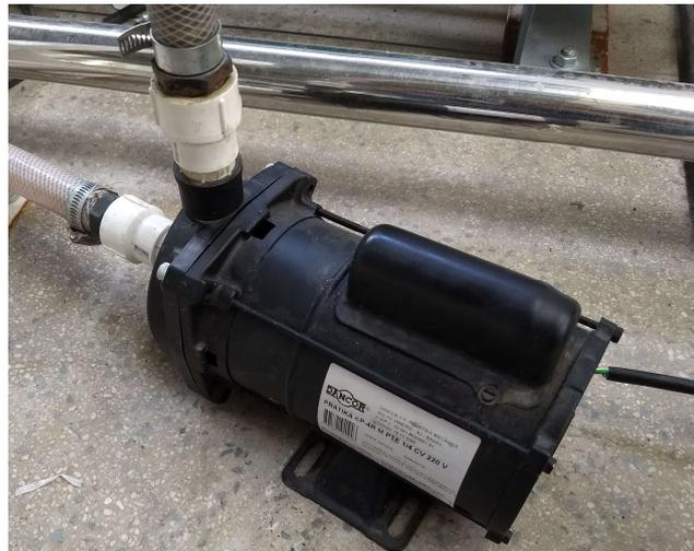
Figura 3.16: Bomba centrífuga de abastecimento do tanque de mistura
