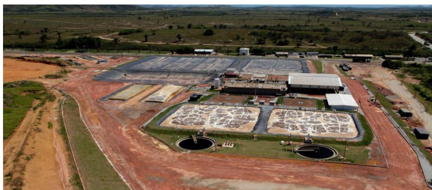
Figura 4.2 – Foto da ETE do aterro BR/RJ 02.
