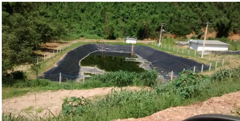
Figura 4.1- Foto mostrando a lagoa de acumulação de lixiviado do aterro BR/RJ 01.
