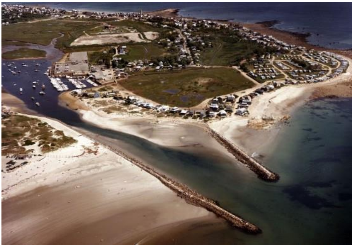
Figura 17. Exemplo do uso de guia-correntes na estabilização de canais de maré em Cape Cod Bay, Massachusetts (Fonte: NEW ENGLAND BOATING, 2019).
