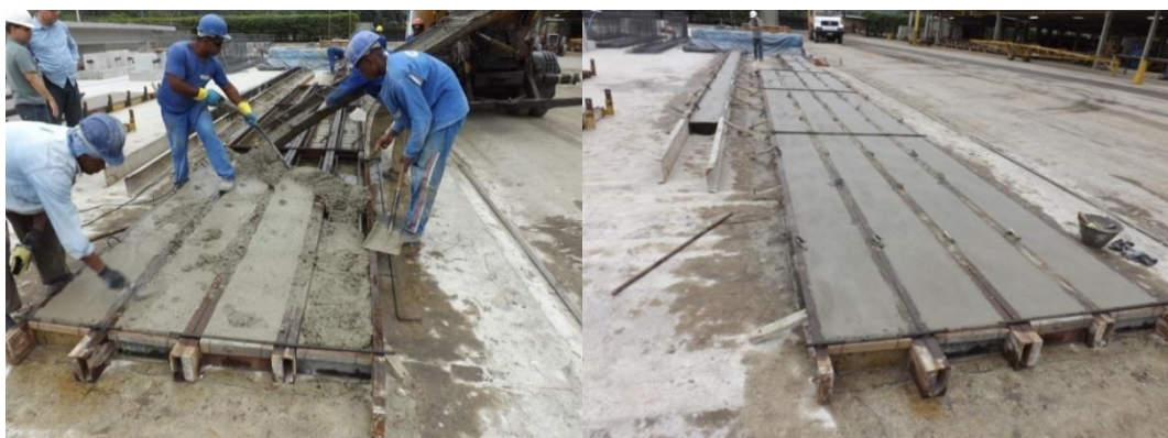
Figura 3.6: Processo de concretagem das vigas.
