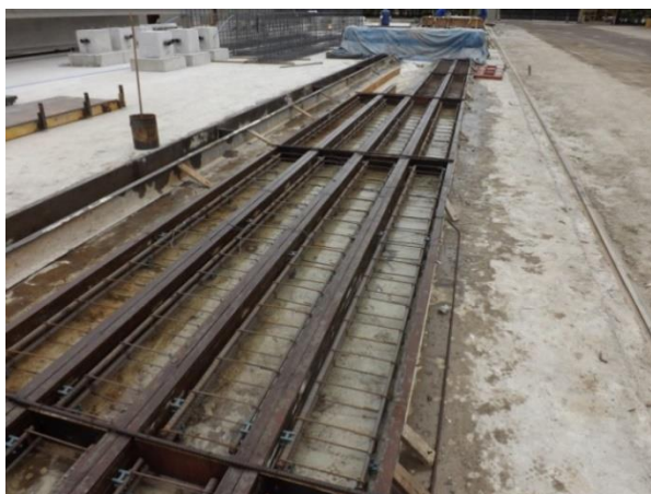
Figura 3.5: Formas utilizadas na concretagem.
