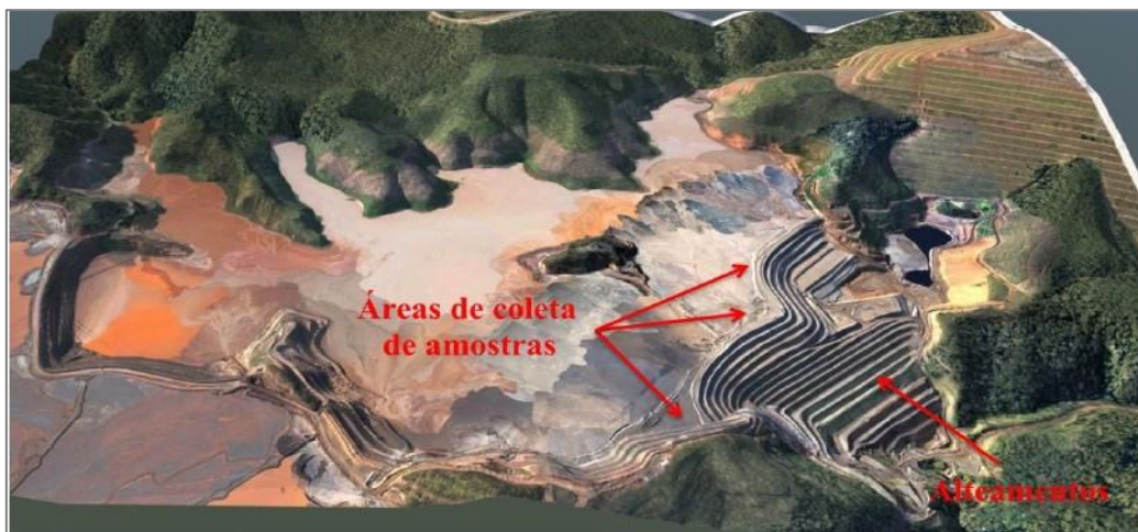
Figura 4.4. Locais de retirada das amostras na barragem (FLÓREZ, 2015)
