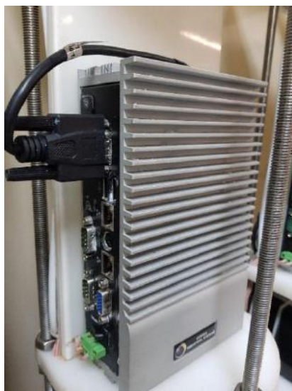
Figura 30: Unidade de processamento ASRock, AD525PV3.
