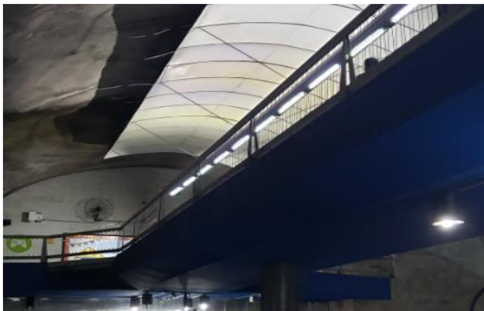
Figura 4.4 – Vista inferior da passarela Fonte: Elaboração própria
