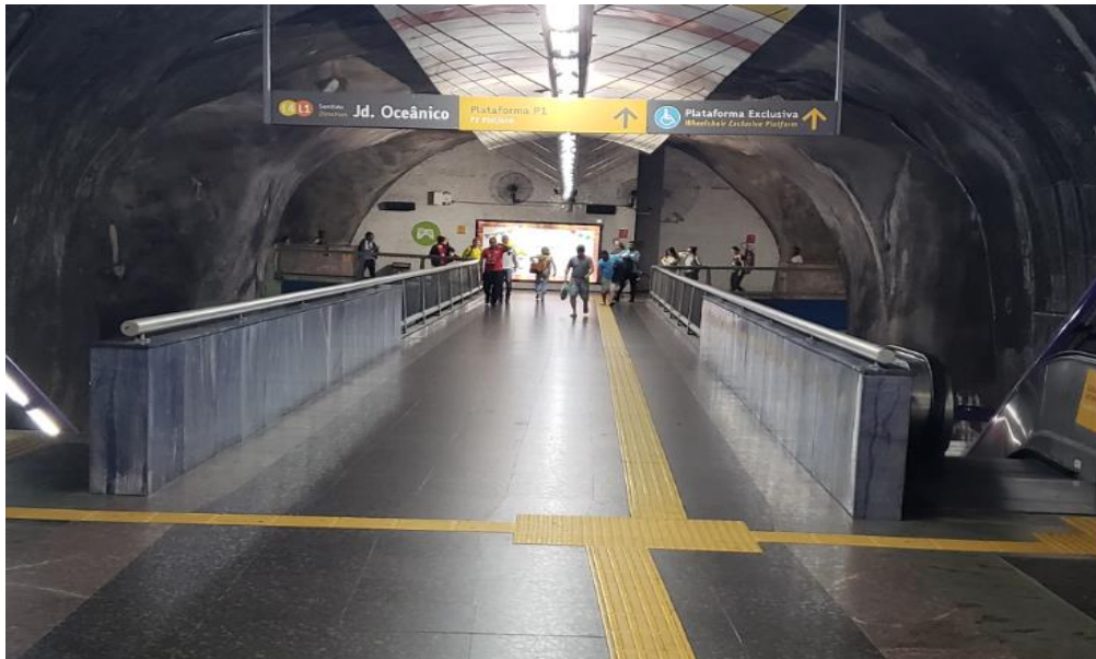
Figura 4.9 – Vista superior da passarela
