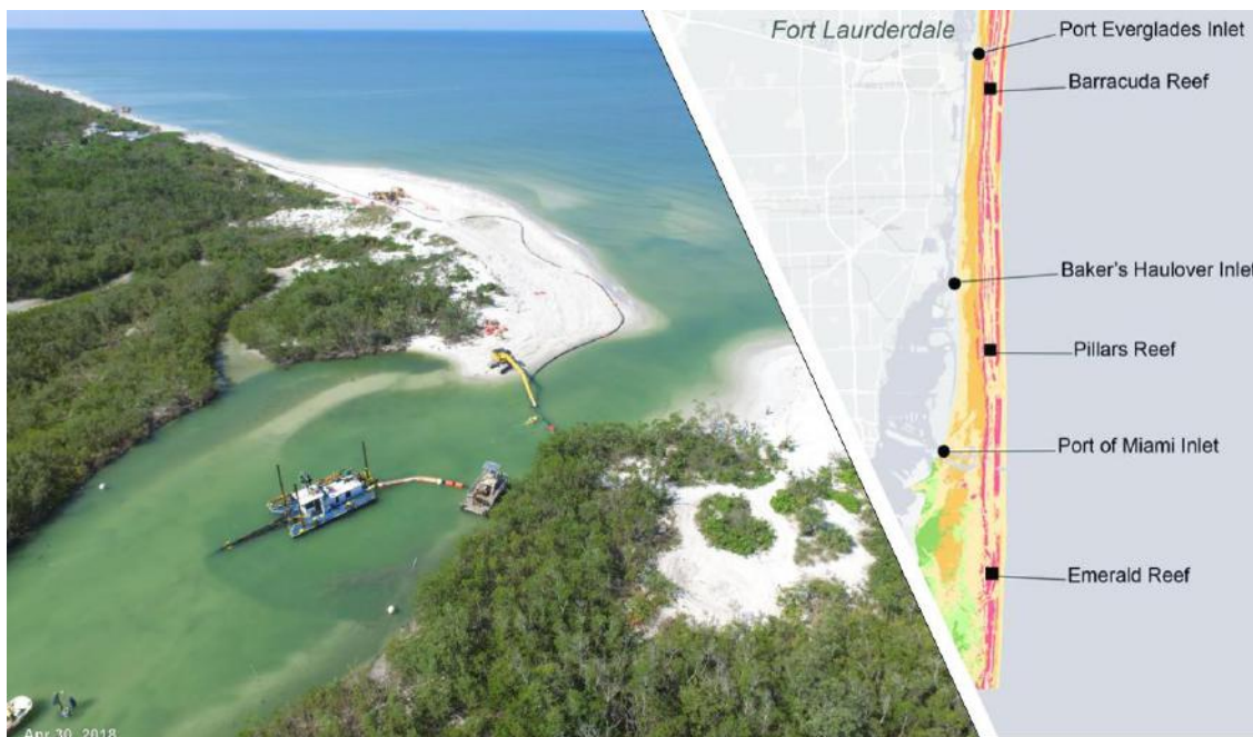
Figura 10. Dragagem de manutenção do canal de maré Baker's Haulover na Flórida, Estados Unidos (CAVACHE INC, 2019).
