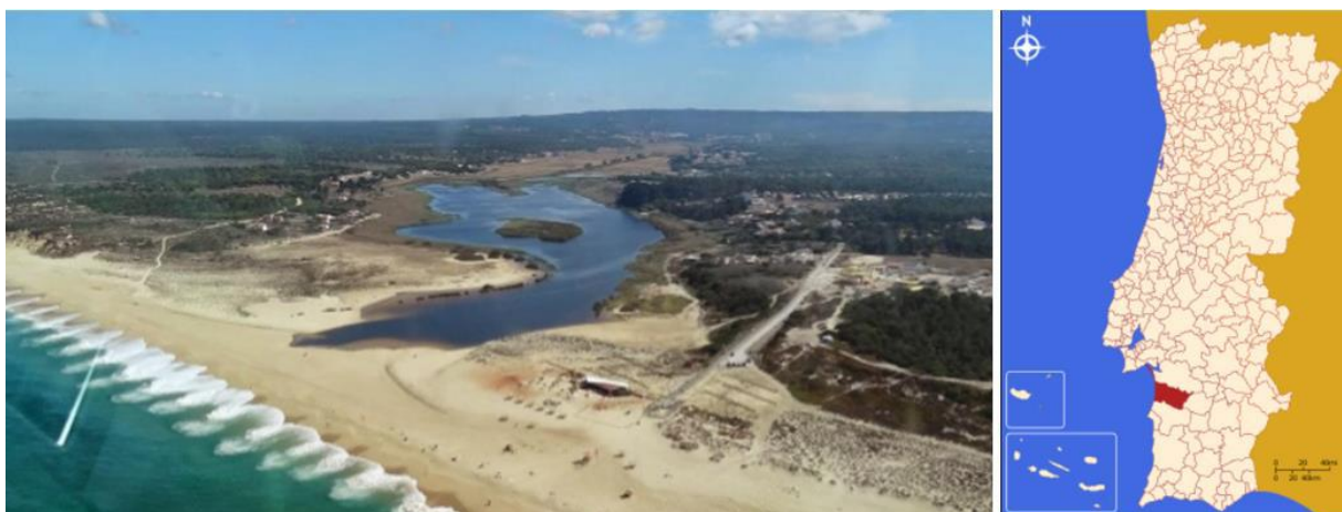
Figura 8. Lagoa de Melides, Grândola, Portugal. Aproveitam as datas equinociais e marés de sizígia para abrir o canal de maré e renovar das águas da lagoa (“A Terceira Dimensão”, 2017).
