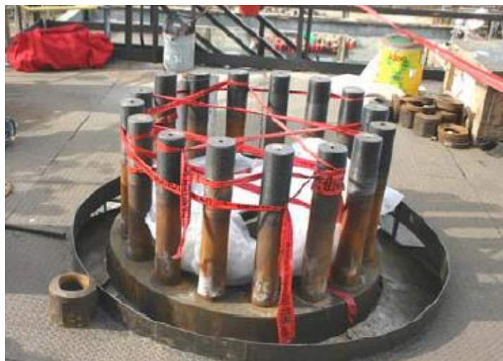
Figura 4.5 – Abertura de 24” por onde o empregado tentou recuperar a fita Reprodução (U.S. CSB, 2006a)
