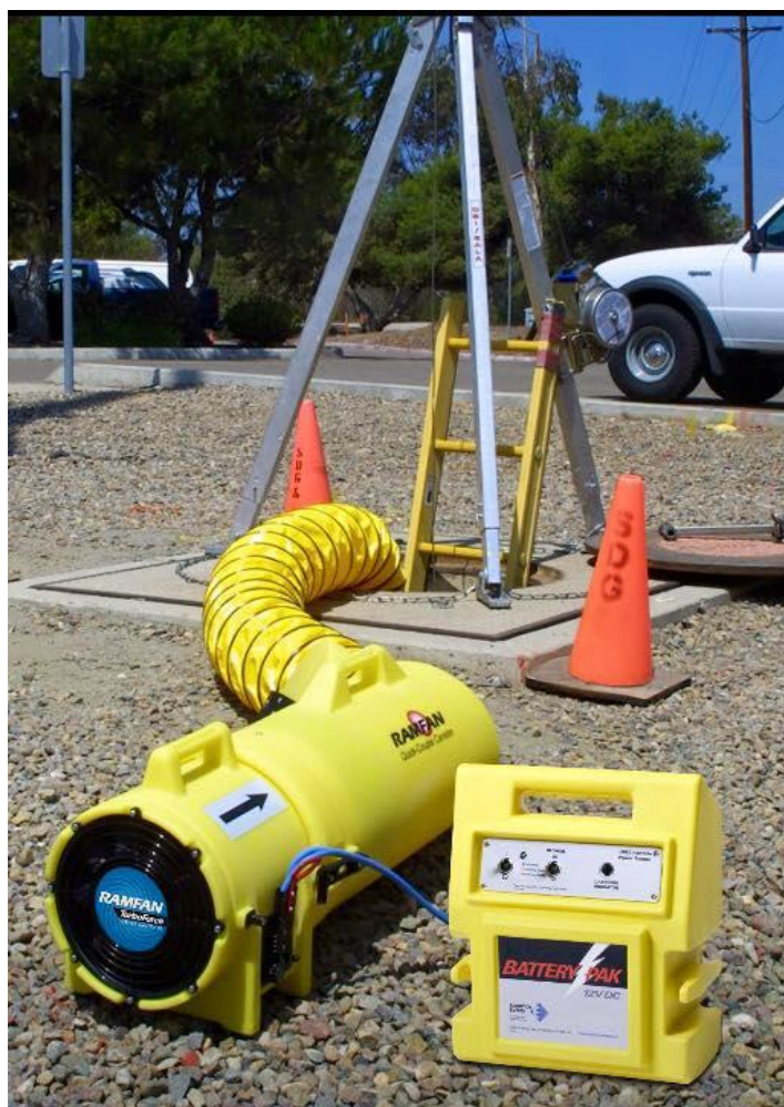
Figura 2.9 – Insuflador renovando o ar de galeria subterrânea (EQUIPE CONECT, 2019)
