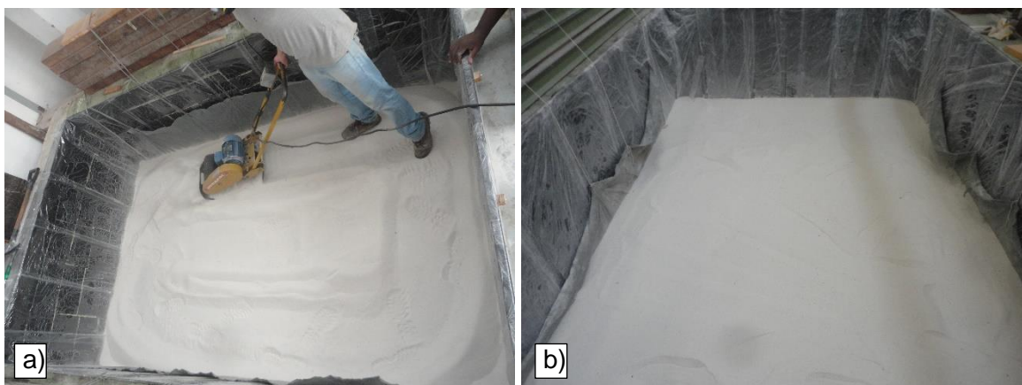
Figura 3.13. a) Compactação em um circuito espiral em direção ao centro, alternando os sentidos entre anti-horário e horário; b) compactação finalizada.
