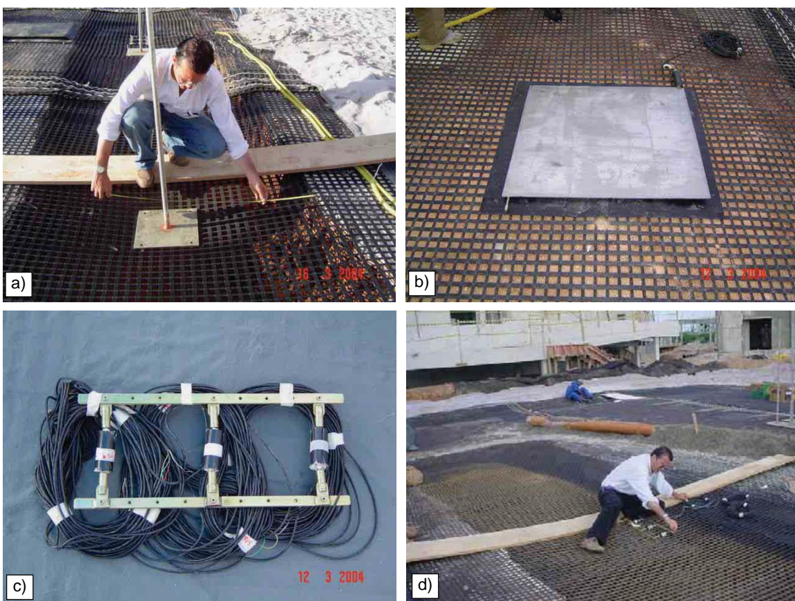
Figura 2.14. a) placa de recalque – PR, instalada no meio do vão entre capitéis; b) célula de tensão total – CP; c) medidor de tração – MT; d) instalação do medido de tração. (SPOTTI, 2006)
