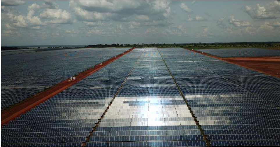
(a) UFV Boa Hora de 76 MW em São Paulo (em construção).
