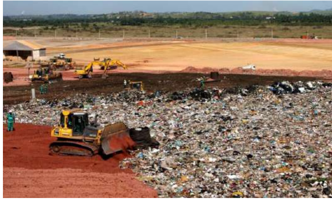
Figura 28: Operação de aterro sanitário - disposição e cobertura de resíduos. Fonte: Internet (2019).
