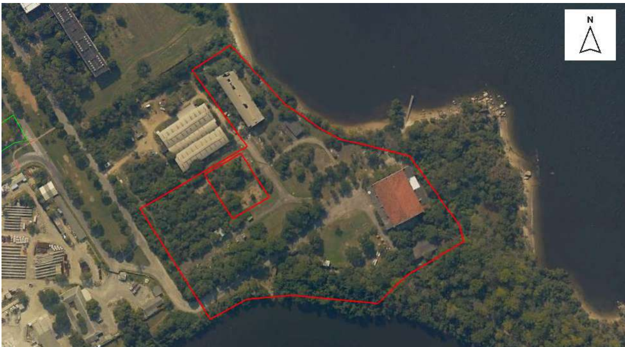
Figura 49: Proposta de localização do pátio de compostagem no Hangar UFRJ. Fonte: Elaboração própria (2020).
