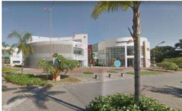
Fig.2 - Prédios administrativo e de serviço
