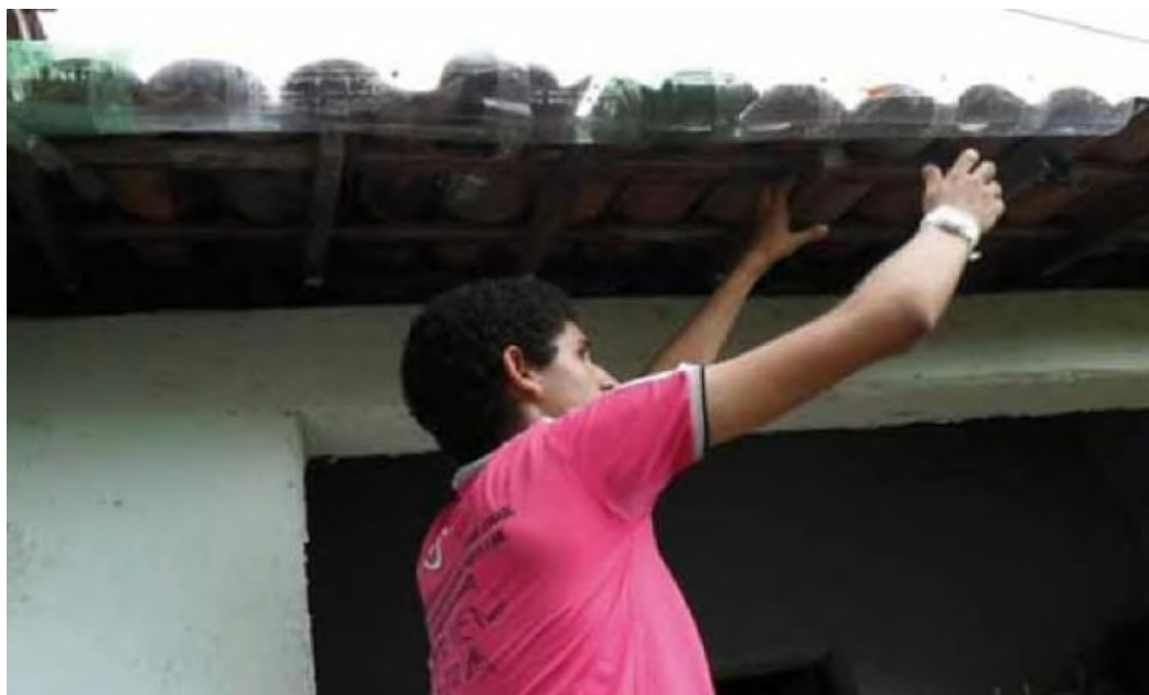
Figura 2. Instalação da calha alternativa feita de garrafas pet
