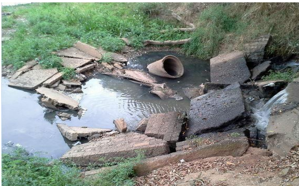
Figura 3. Lançamento de esgoto não tratado no rio Piraciba, SP
