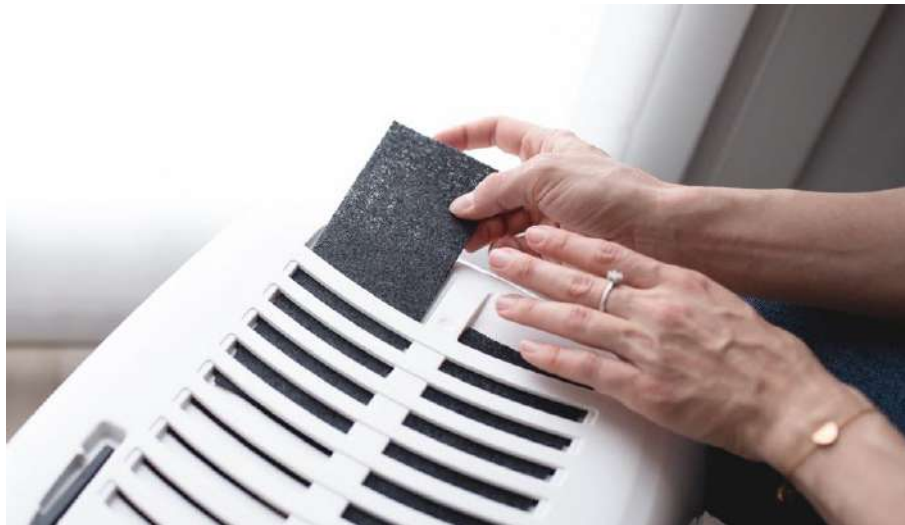
Figura 41 - Dona trocando o filtro de carvão ativado na cobertura da bacia
