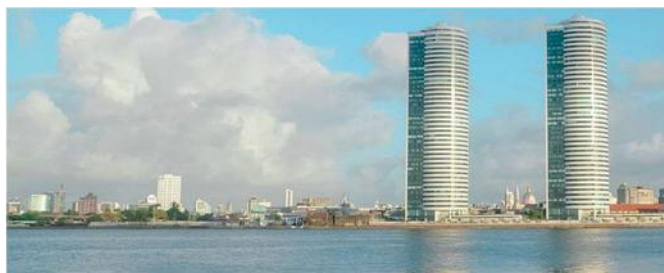
Fig. 19. Os edifícios PIER Maurício de Nassau e PIER Duarte Coelho vistos da margem oposta da Baía do Pina, em Brasília Teimosa. Fonte: Brasil de Fato PE 226 .
