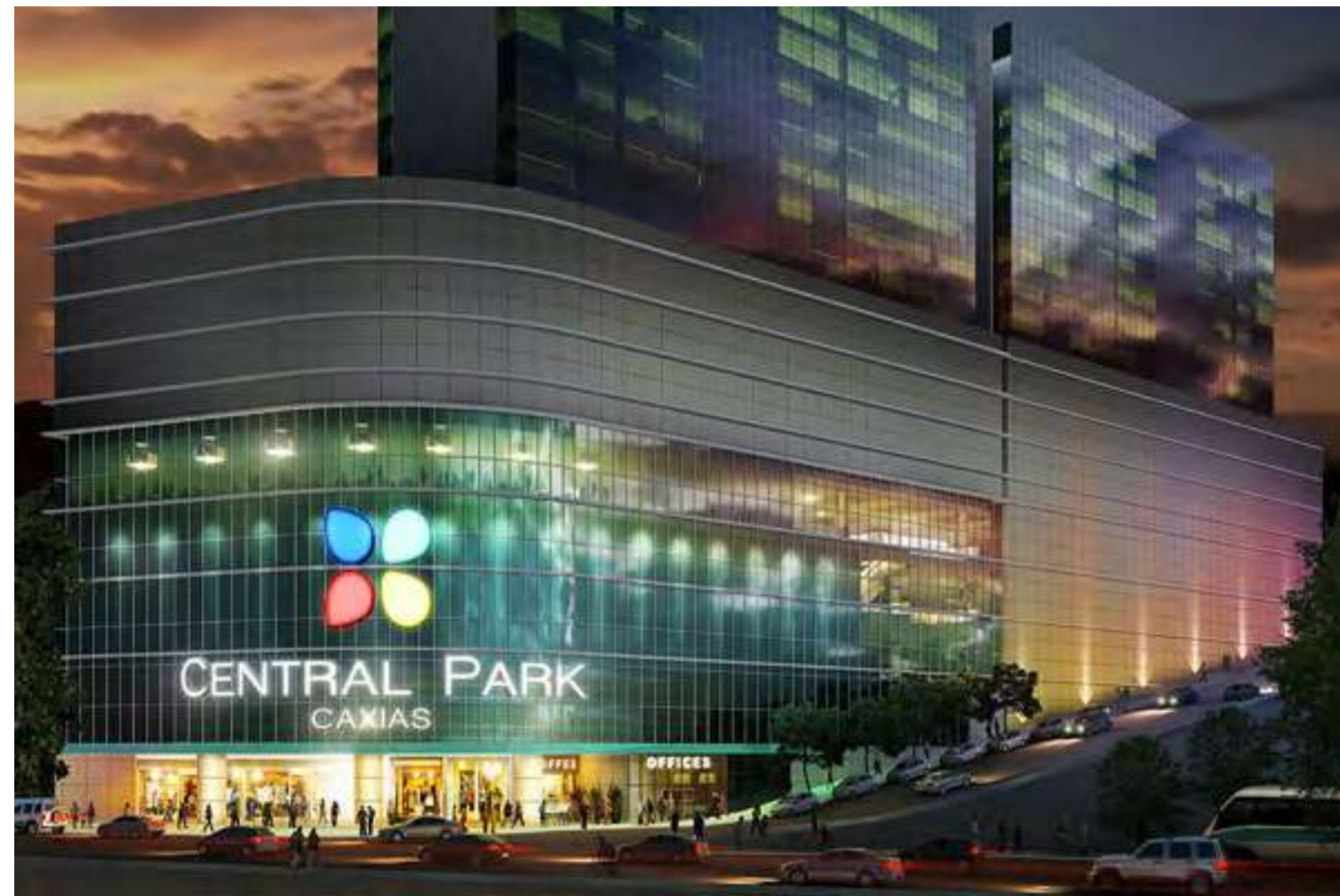
Fachada Projeto Shopping Central Park Caxias.
