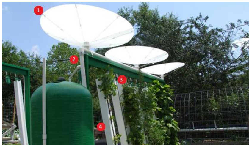
Figura 24: sistema de aproveitamento de água de chuva
