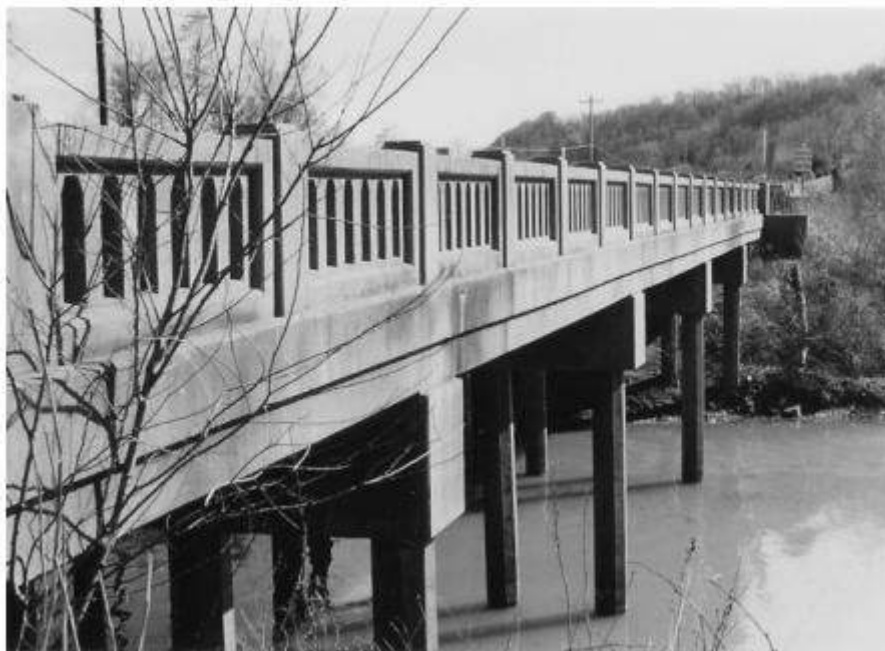
Figura 2.9: Ponte Teens Run Bridge , estado de Ohio, EUA. Fonte: BURKE (2009).
