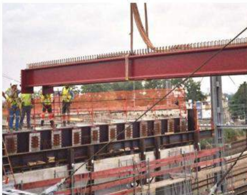
Figura 4.8: Montagem de viga de aço içada por guindaste. Fonte: HECHLER (2009).
