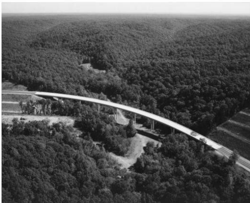
Figura 2.8: Ponte Happy Hollow Creek , estado do Tennessee , EUA. Fonte: BURKE (2009).
