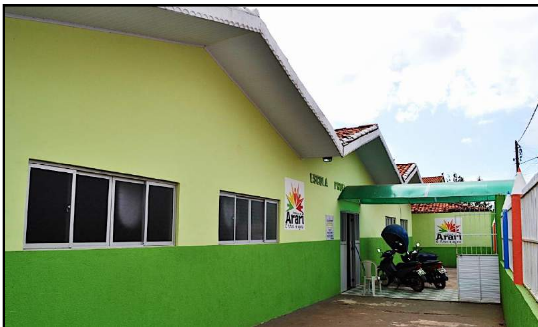
Figura 41 - Foto da entrada da E.M. Professora Luiza Francelina, na zona urbana de Arari – MA
