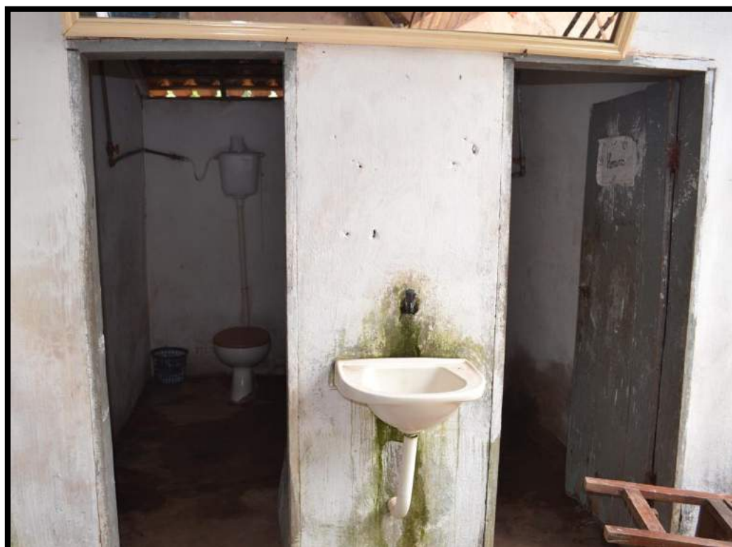
Figura 66 - Foto das instalações sanitárias da Escola Municipal de Moitas Fonte: Autoria própria
