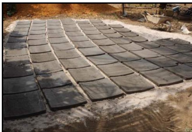
Figura 11 – Centro de construção de placas de cimento para a cisterna
