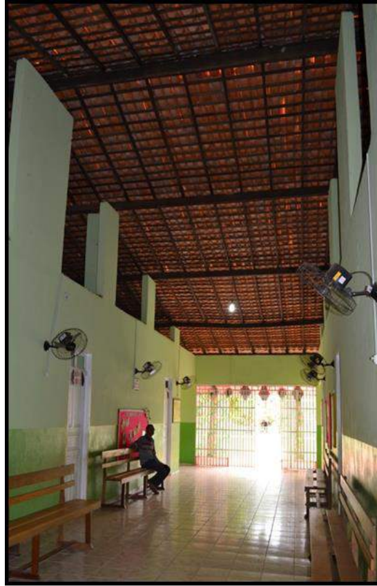
Figura 57 - Foto do Corredor da E.M. Modesto Prazeres que permite ver a grande dimensão do telhado da escola. Fonte: Autoria própria
