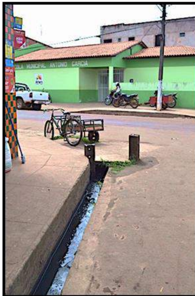
Figura 49 - Foto da rua em frente a entrada da escola com esgoto correndo na sarjeta Fonte: Autoria própria
