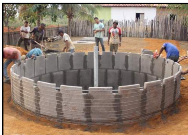
Figura 12 – Construção da cisterna de placas
