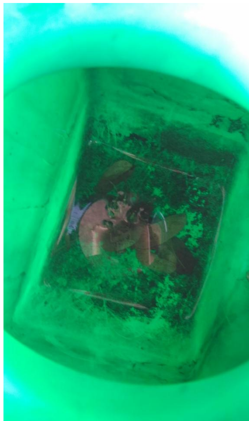
Figura 38 - Verificação de acúmulo de água com resíduos no interior do Chove Chuva.
