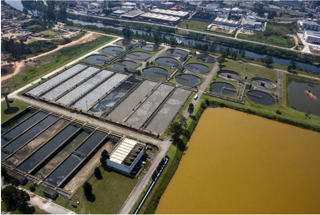
Figura 3: Cogeração de energia com lodo de esgoto. Fonte: Grupo Liberal (2016).
