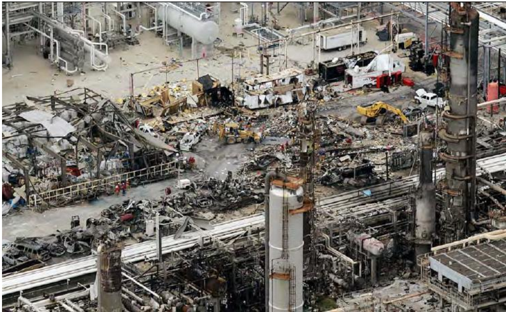
Figura 22 - Danos na instalação da Cidade do Texas da Refinaria da BP
