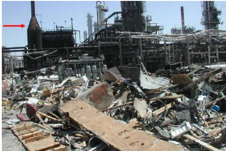
Figura 32 - Trailers destruídos após a explosão
