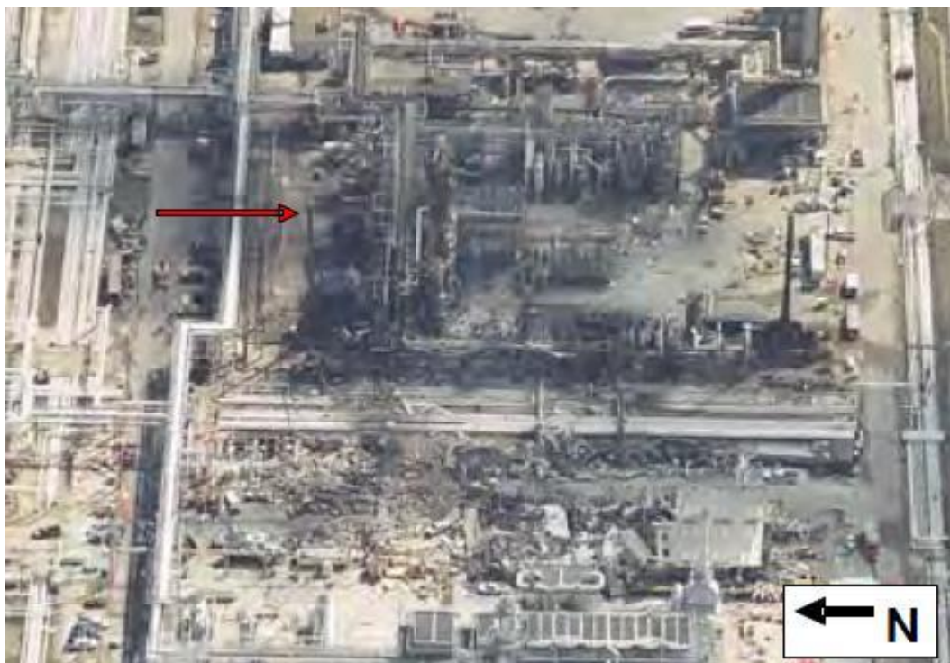
Figura 31 - Planta da Refinaria BP após os incêndios
