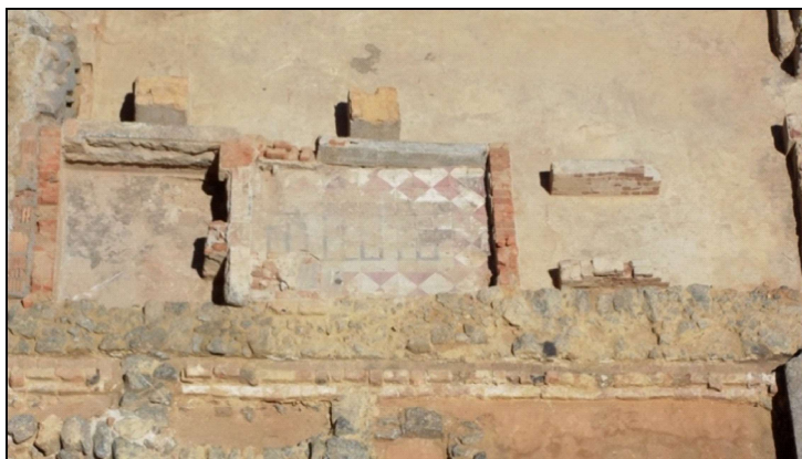
Figura 54. Cômulo da parte dianteira da casa, recoberto de ladrilhos hidráulicos. Foto das autoras.
