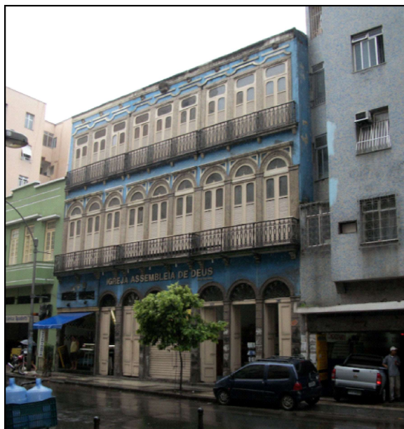
Figura 17. Três unidades residenciais geminadas em sobrados de três andares à Rua Riachuelo nºs 141, 143 e 145. Edifício transformado em templo da Assembleia de Deus. Foto: T. Andrade Lima.
