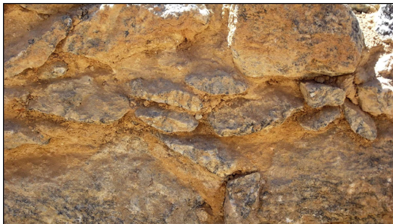
Figura 68. Detalhe da argamassa de cal e areia utilizada na confecção do alicerce. Foto das autoras.
