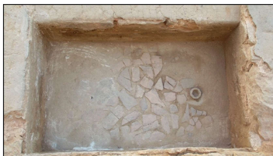
Figuras 82 e 83. Tanque do galpão em alvenaria de tijolo, forrado de cacos de telhas. Fotos das autoras.
