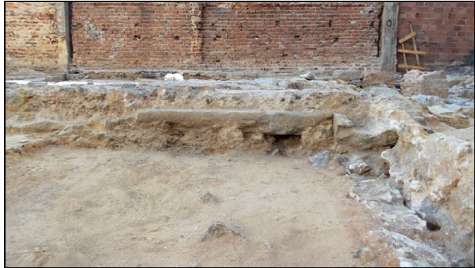
Figura 28. Aterro para a elevação da área do pátio dos fundos, com reaproveitamento de materiais, como uma grande laje de pedra e um segmento de canaleta em pedra lavrada, trazidos de outros locais
