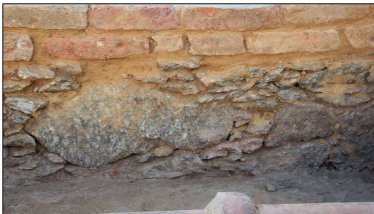
Figura 67. A primorosa alvenaria do lote nº 370, e arranque de parede em tijolos maciços com argamassa de cal e areia. Foto das autoras.
