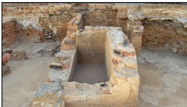
Figura 66. Reservatório em alvenaria de tijolos e cimento, acoplado ao alicerce divisório do nº 372.
