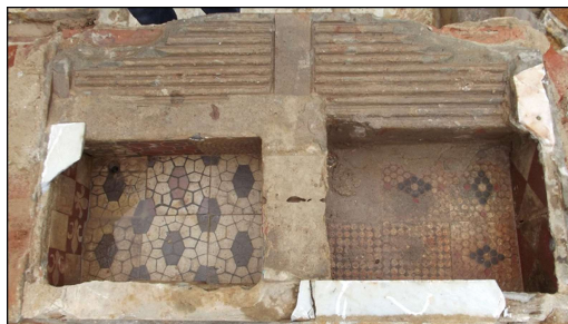
Figuras 51 a 53. Tanque duplo e muito raso, recoberto com patchwork de ladrilhos hidráulicos e moldura de mármore branco, em alvenaria de tijolos com cimento. Fotos das autoras.
