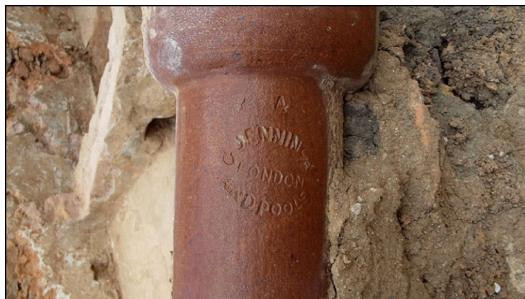
Figura 61. Tubos ingleses, com a marca G. Jennings/ London/ and Poole (George Jennings [1810-1882], engenheiro sanitário, especialista em banheiros públicos e produtos sanitários no século XIX). Foto das autoras.
