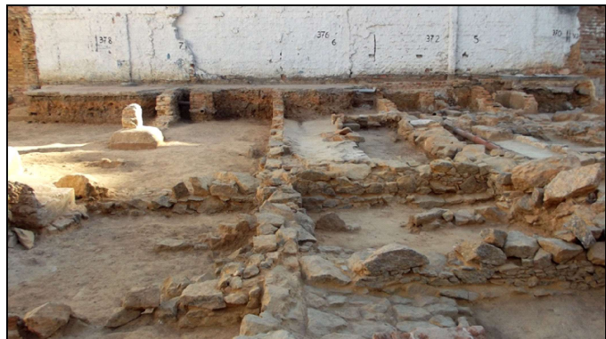
Figura 76. Ao fundo, à esquerda, a sapata de concreto feita para a construção de um galpão nos fundos dos lotes nºs 376, 378 e 380, que eliminou suas estruturas originais. Foto das autoras.
