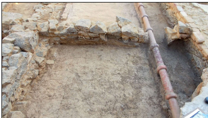
Figura 62. Destruição de alicerce para passagem de tubulação no lote nº 370. Foto das autoras.
