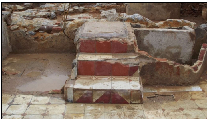
Figura 56. Lance inicial da escada de acesso ao segundo piso, forrada com ladrilhos, e faixa em motivos geométricos para completar a largura do degrau. Foto das autoras.
