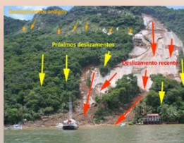
Vista do deslizamento da Ilha Grande onde existia a Pousada Sankay. A área era de alto risco por estar situada em encosta muito íngreme onde vários deslizamentos já haviam ocorrido no passado.
