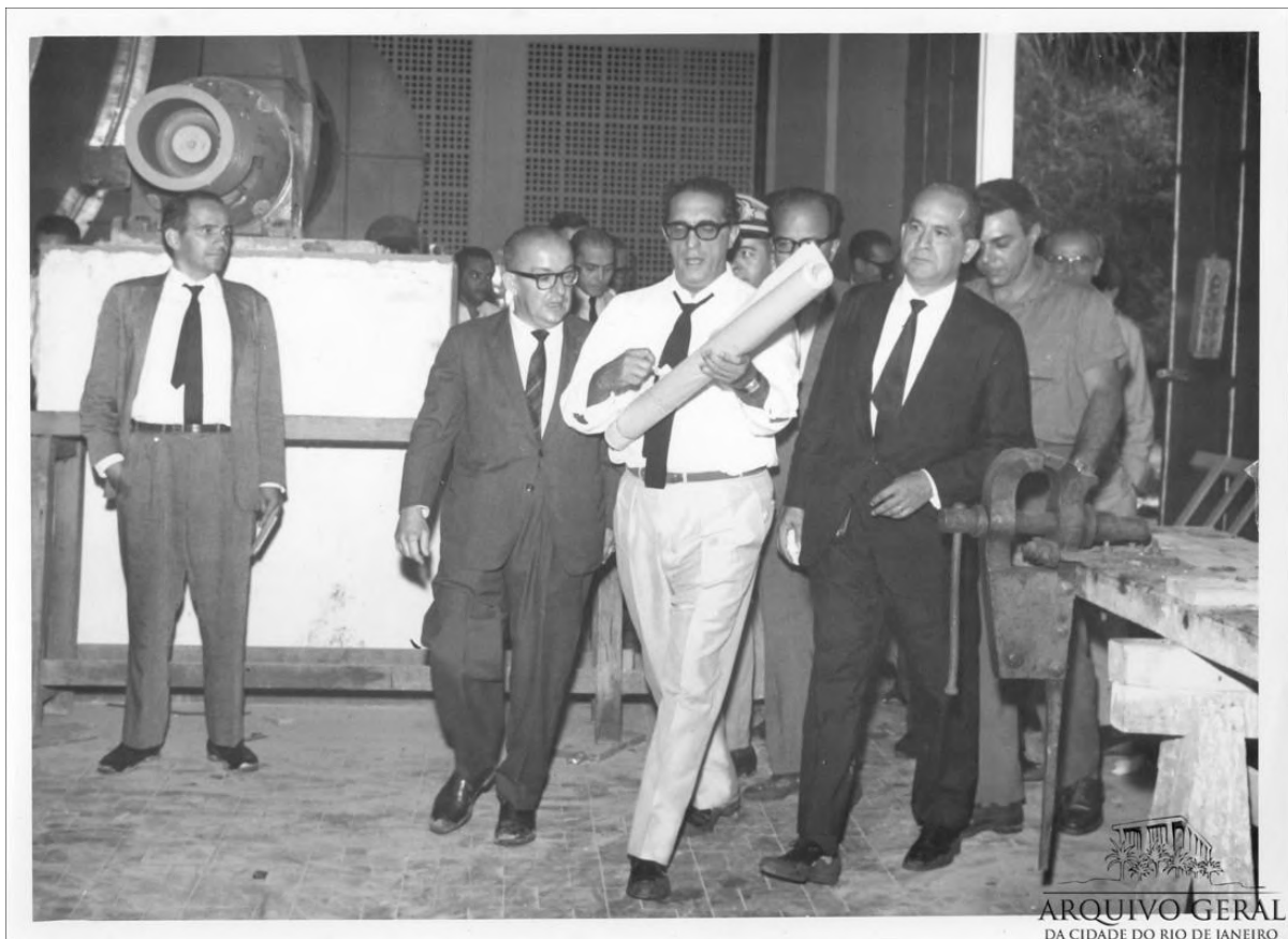
Figura 5: Lacerda visita as obras do Túnel Rebouças, 1965. Rio de Janeiro (RJ), Rio de Janeiro (Brazil), Rio Comprido (Rio de Janeiro, RJ) / Arquivo Geral da Cidade do Rio de Janeiro
