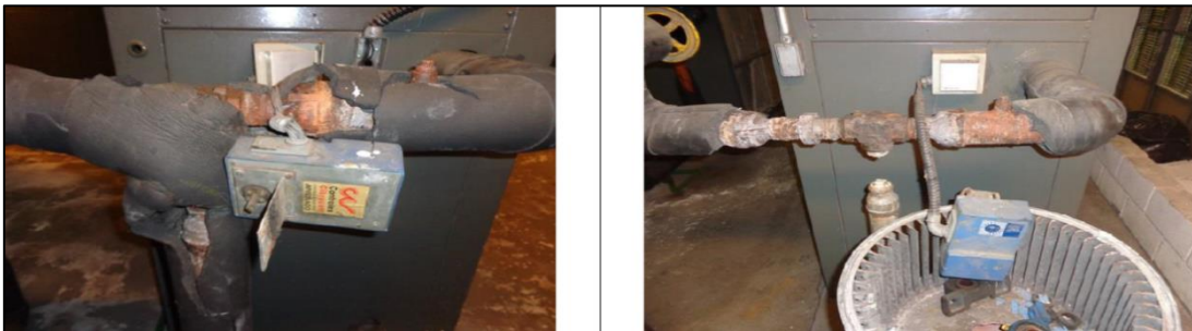
Figura 8.2 - Válvula de três vias do sistema atual.
